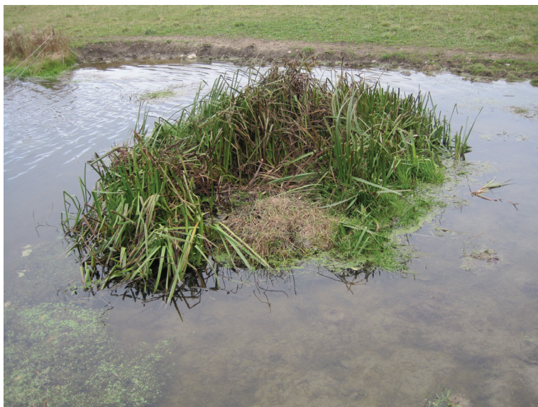
Figur 7. Helt igensatt kupolsil till en utloppsbrunn
