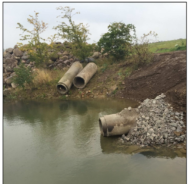
Figur 105: Renoverat inlopp, Sjöbo 91
