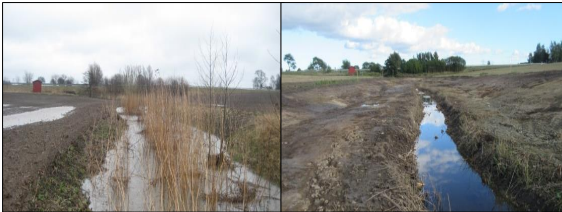
Det anlagda tvåstegsdiket vid högflöde innan anläggning samt efter anläggning.
