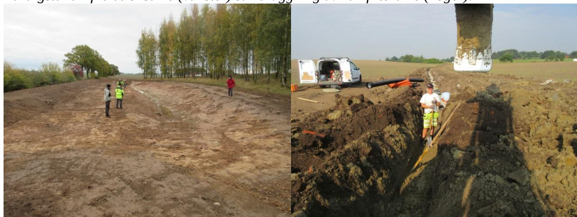
Färdigställt infiltrationsdike (vänster) samt läggning av kalkfilterdike (höger).
