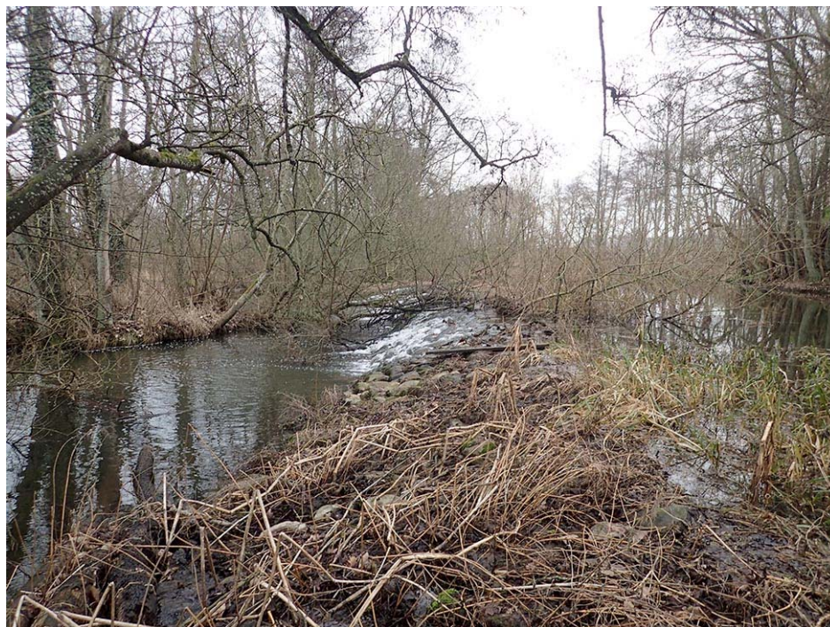
Figur 39. Vy över dämmet vid Håstadmölla taget från kvarnen och uppströms (foto 2017).
