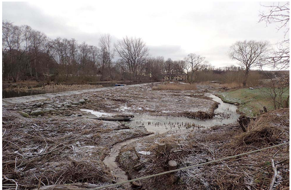
Figur 46. Dämmets anslutning till den norra stranden där åtgärder för fiskvandring kan genomföras (foto 2017).
