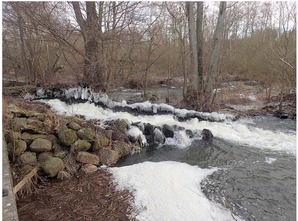
Figur 16. Laxtrappa vid dämmets nedre del byggd 1948 med kar av betong och natursten (foto 2017).
