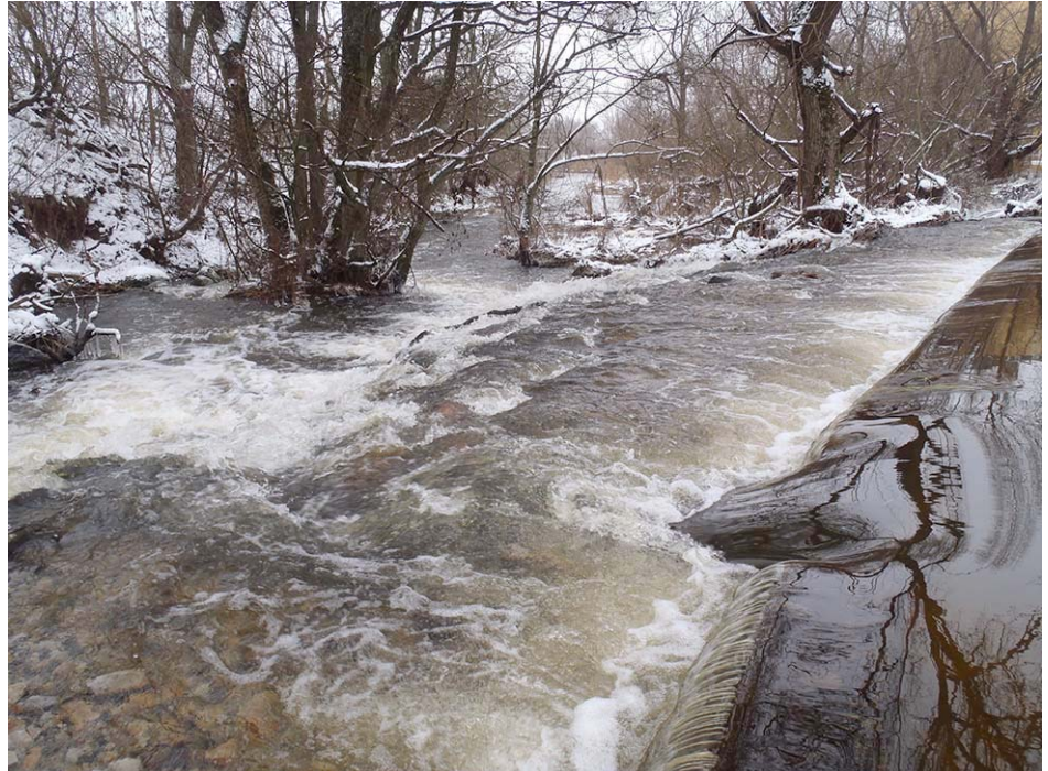
Figur 29. Fiskväg vid dämmets övre del på åns södra sida byggd år 2010 (foto 2010).
