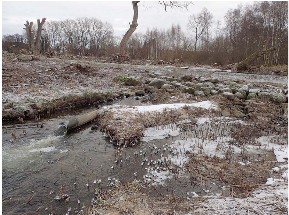
Figur 12. Vy över dämmet vid Högs Mölla vid landfästet på den norra sidan med rör som går under dammen som förser området nedströms dammen med ett visst flöde (foto 2017).
