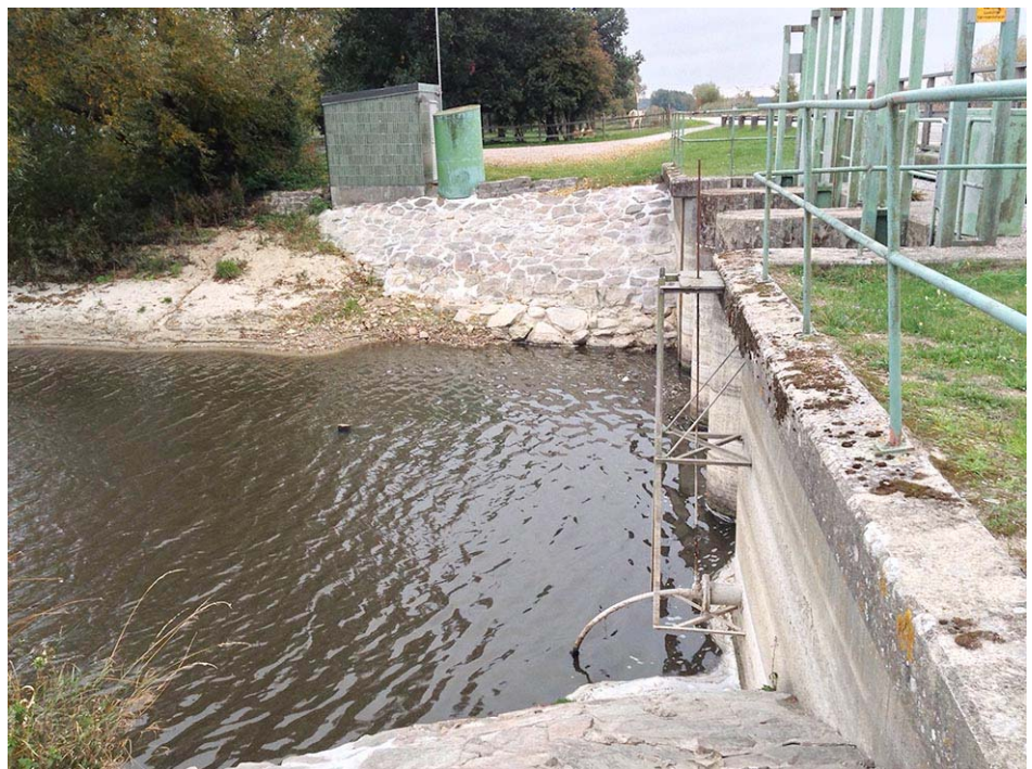
Figur 45. Utloppet vid Vombsjön med reglerings luckor (foto 2013).
