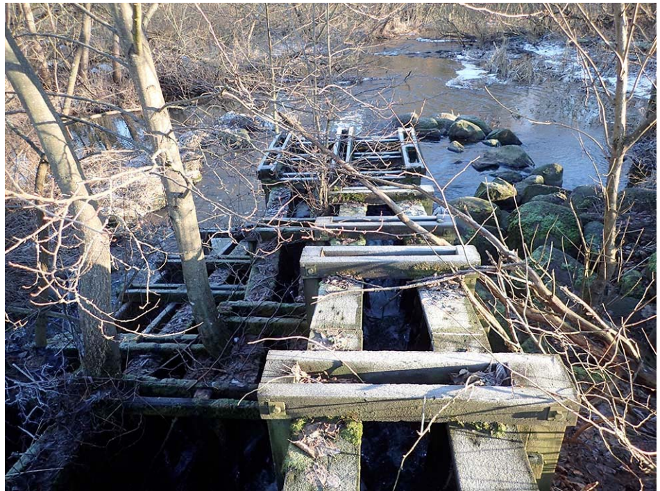
Figur 17. Fiskväg av typ motströmsränna (denilränna) vid dämmets nedre del byggd under 1980-talet (foto 2017).
