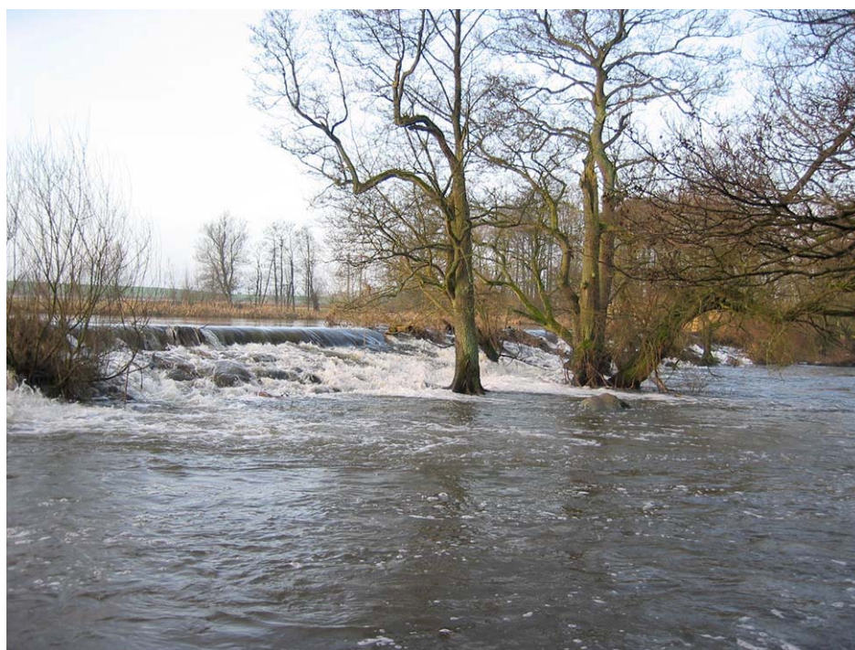
Figur 34. Vy över dämmet vid Kvarnvik taget från norra sidan mot södra sidan (foto 2005).
