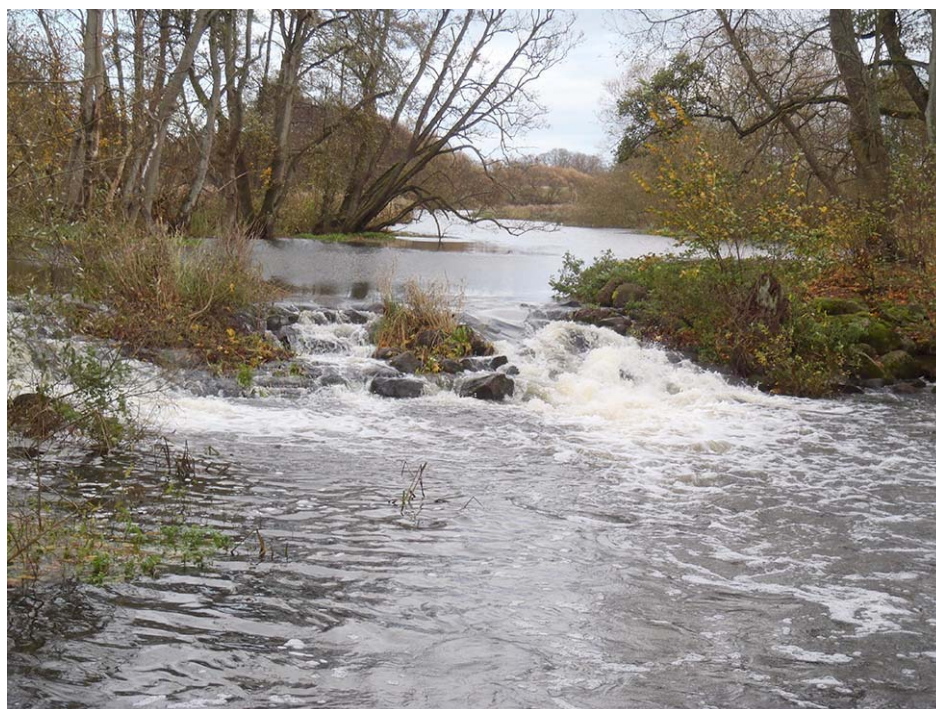
Figur 22. Fiskväg vid dämmets övre del på åns södra sida byggd år 2007 (foto 2013).
