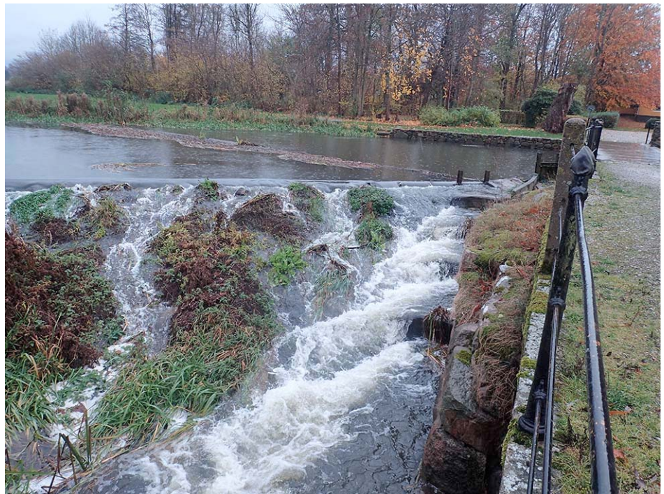
Figur 33. Fiskväg på åns södra sida byggd år 2001 (foto 2016).
