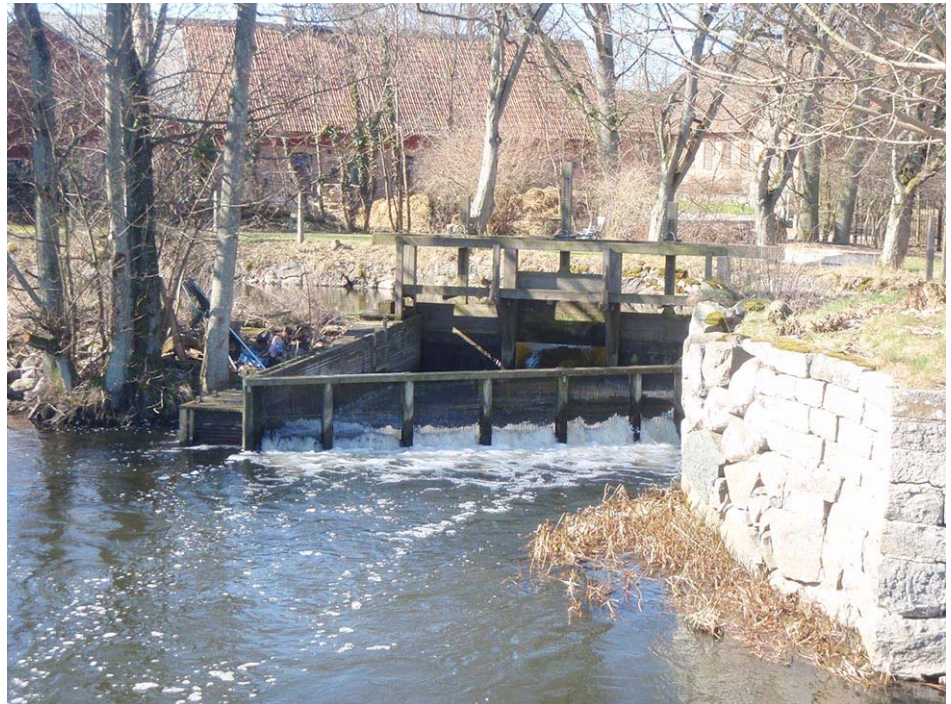
Figur 42. Fiskfällan (Wolf-trap) vid Håstadmölla ligger i nedre delen av kvarnrännan och mynnar i åfåran nedströms dämmet. (foto 2010).
