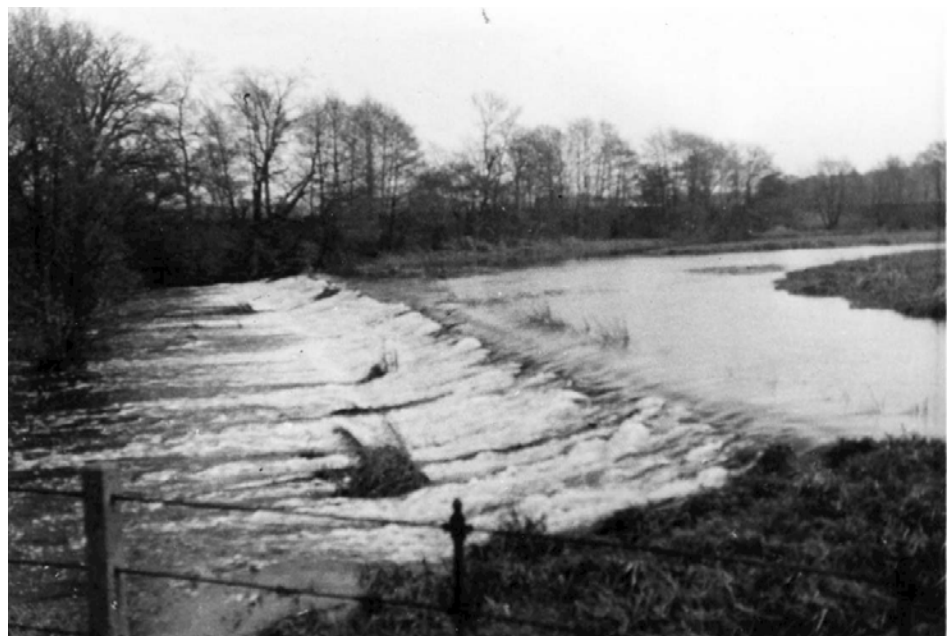
Figur 32. Historiskt foto över dämmet vid Bösmöllan, taget från södra sida (1945, arkiv bild, Svenska lax och laxöringföreningen UPA).
