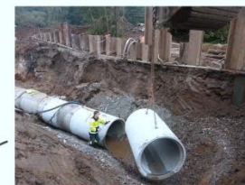
I den nya anläggningen har betongakvedukten ersatts med en dykarledning under Björkaån
