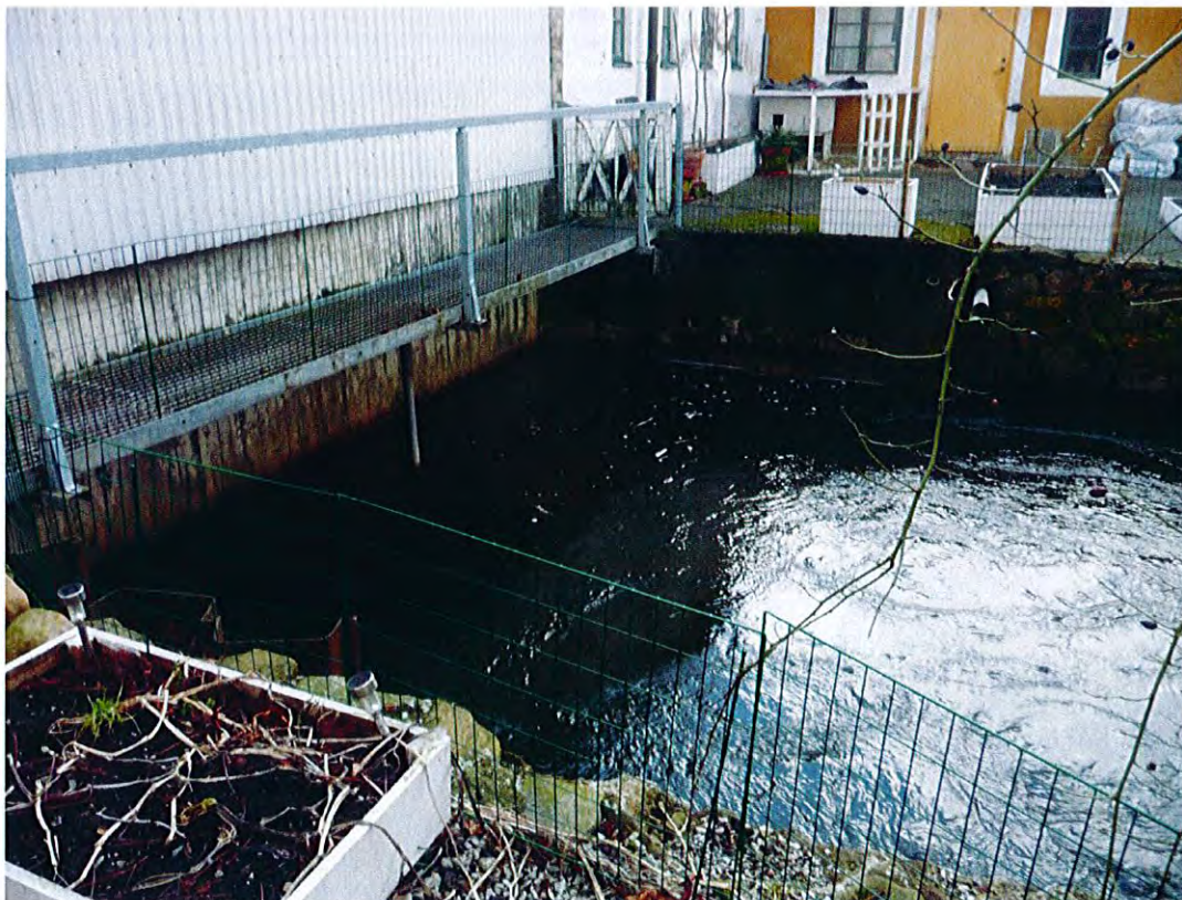
Figur 4.8 Utløppskanal för G2 och G3 vid Bösamöllan 1:1.
