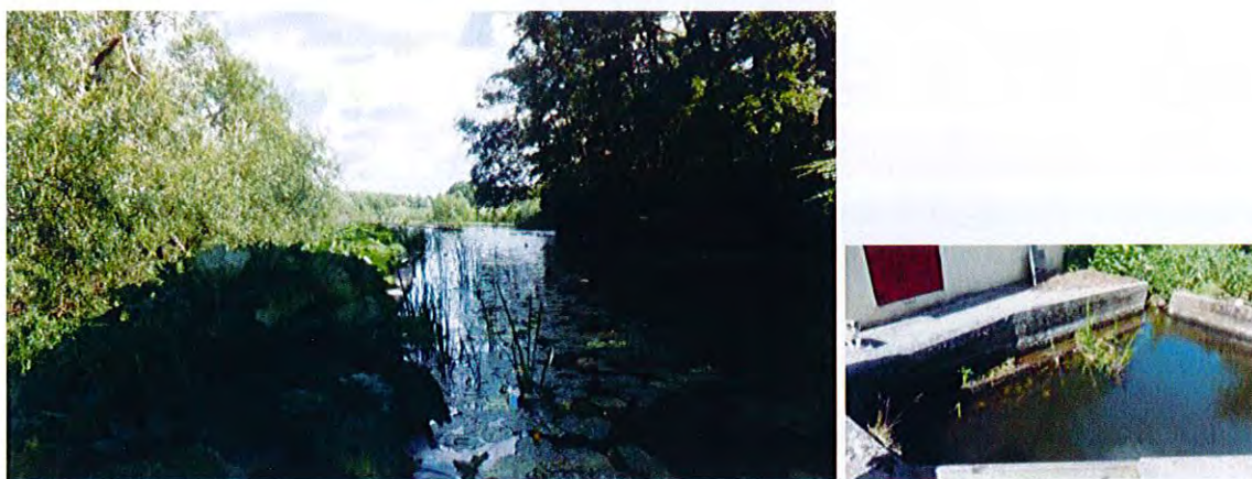
Figur 20. Damnvall vid Kvarnviks valskvarn (vänster i figur) och befintligt fiskgaller vid det mindre kraftintaget (höger i figur). Foto taget vid låg vattenföring 18 juni 2014
