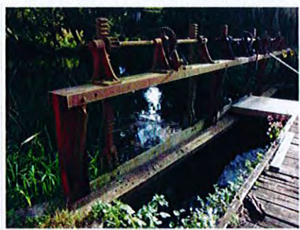
Fiskgaller, 67 graders lutning, spaltbredd ca 14-17 mm
