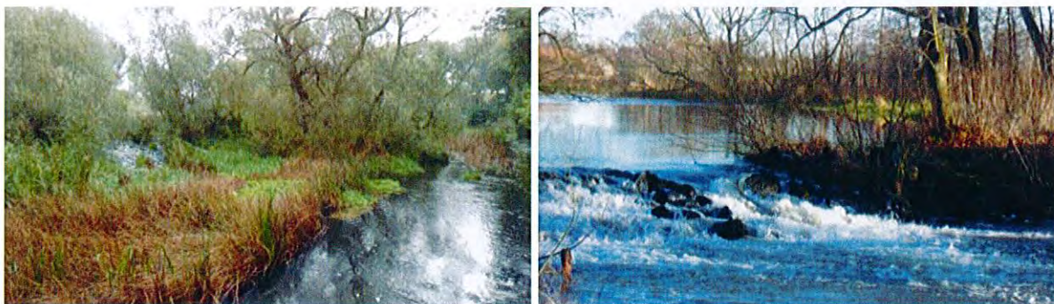
Figur 10. Dammvallen vid Rinnebäck. På åns södra sida har en öppning skapats för att tillåta fisk att passera (foto hämtat från Löddeåns och Kävlingeåns FVO).
