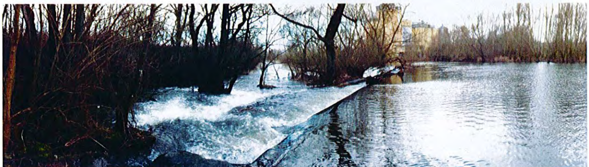
Figur 16. Fiskväg vid Lilla Harrie vid hög vattenföring. Foto taget 3 mars 2015.
