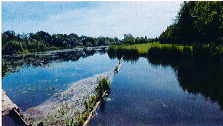
Figur 7. Damm uppströms Bösmöller.
