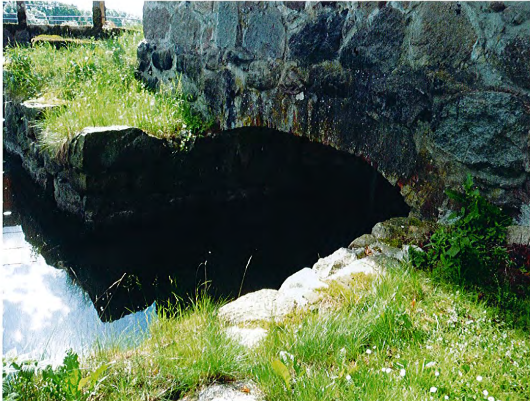
Figur 4.7 Utloppskanal från G1 vid Bösamöllan 1:1.
