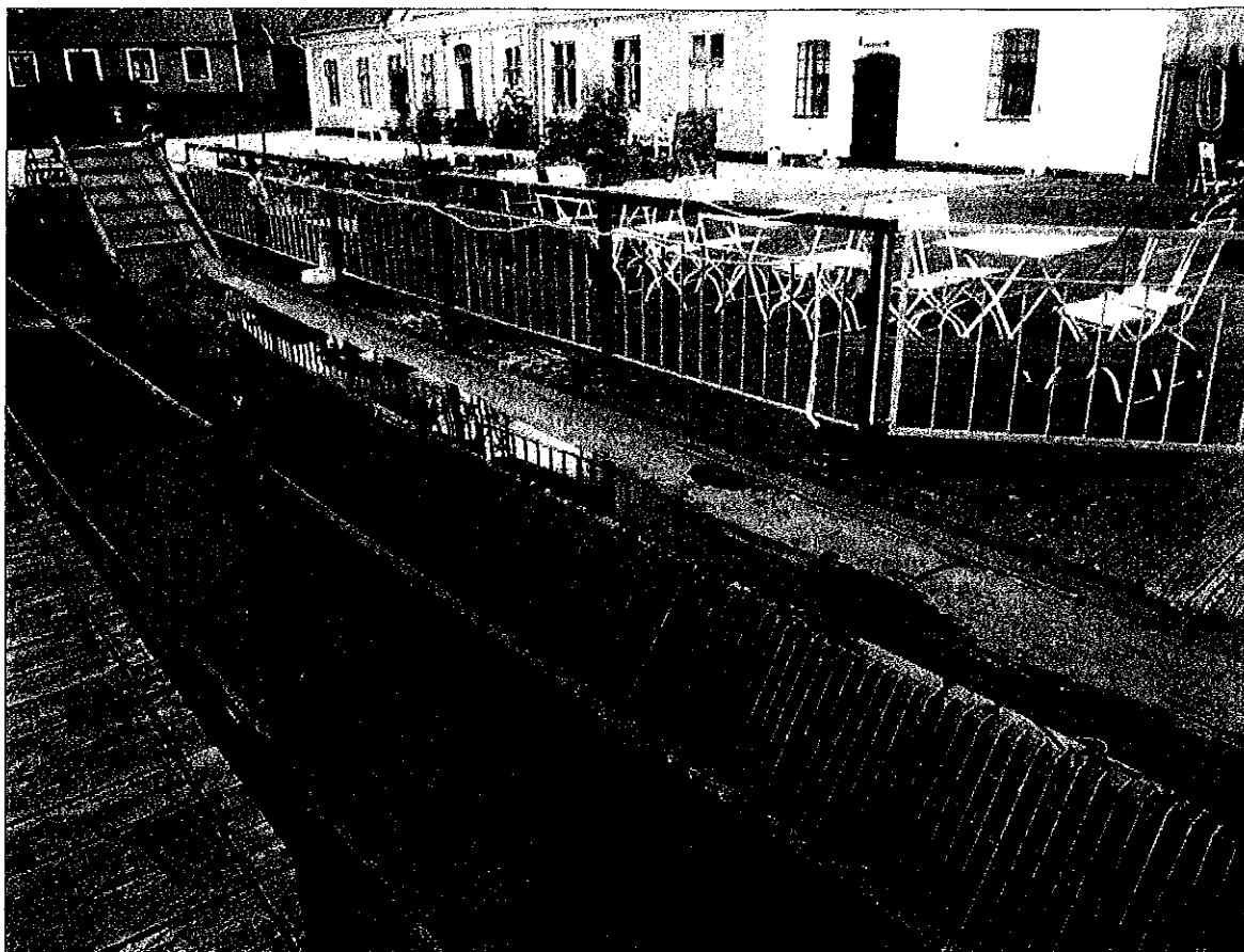
Figur 9. Nuvarande rensgaller där den nedre delen av gallret har en spaltbredd av ca 50 mm.
