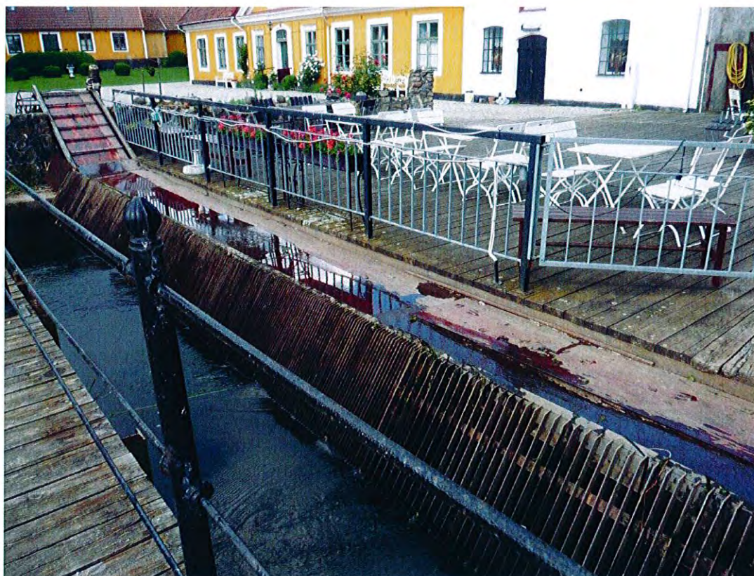
Figur 4.4 Foto visande nuvarande rensgaller där den nedre delen av gallret har en spaltbredd av ca 50 mm.
