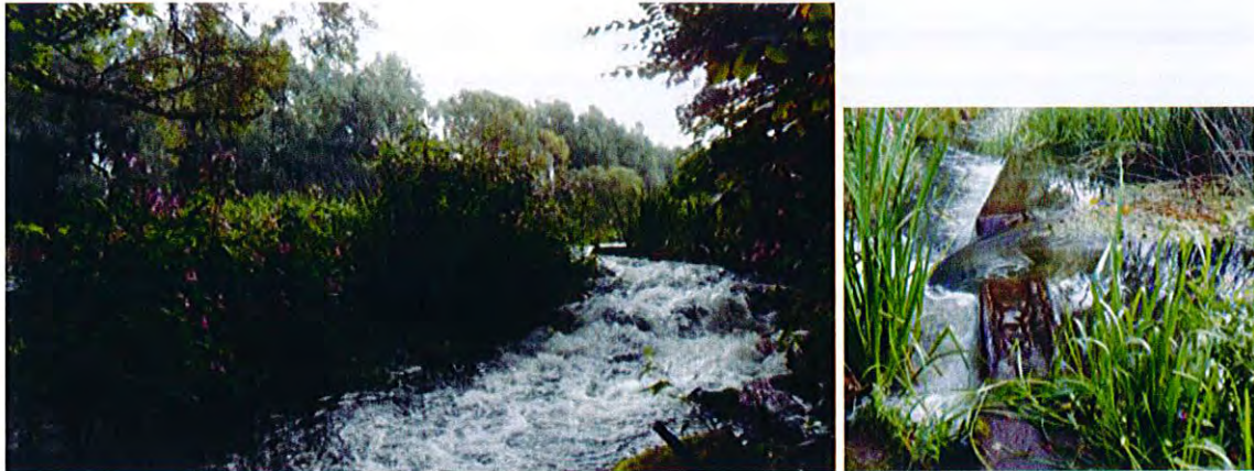
Figur 15. Befintlig fiskväg med utskov i damvallen vid Lilla Harrie. Foto tagna vid låg vattenföring den 26 augusti 2014.
