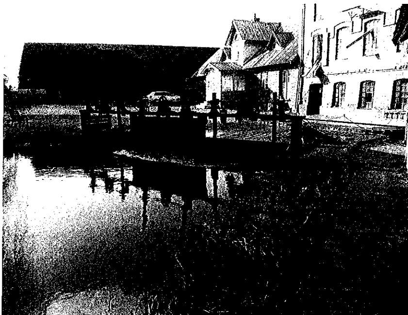
Figur 4.3 Foto visande dammluckor framför rensgaller till T1.
