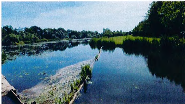
Figur 7. Damm uppströms Bösmöllan.
