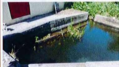
Figur 20. Dammvall vid Kvarnviks valskvarn (vänster i figur) och befintligt fiskgaller vid det mindre kraftintaget (höger i figur). Foto taget vid låg vattenföring 18 juni 2014
