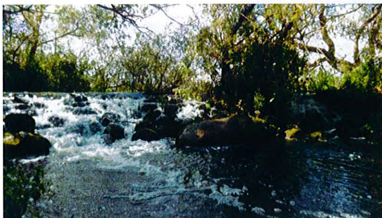
Figur 23. Överfall vid dammvallen på åns norra sida vid Kvarnviks valskvarn.
