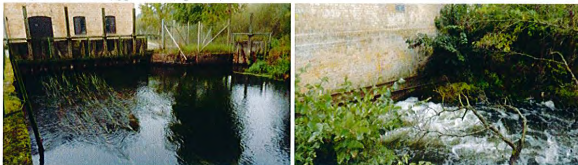
Figur 13. Inlopp till kvarnbyggnad (vänster i figur) och utlopp ut ur kvarnbyggnad (höger i figur).
