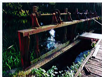
Fiskgaller, 67 graders lutning, spaltbredd ca 14-17 mm
