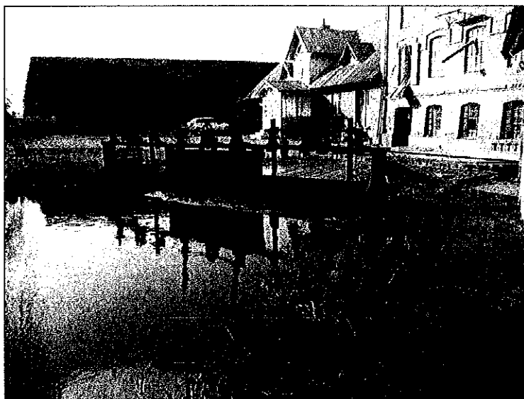
Figur 8. Dammluckor framför rensgaller till T1.
