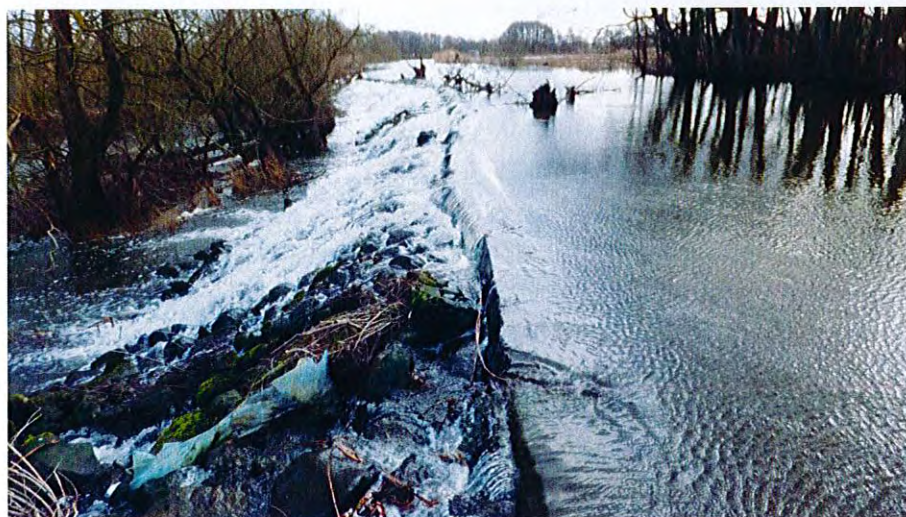
Figur 21. Dammvall vid Kvarnviks valskvarn. Foto taget vid hög vattenföring 3 mars 2015
