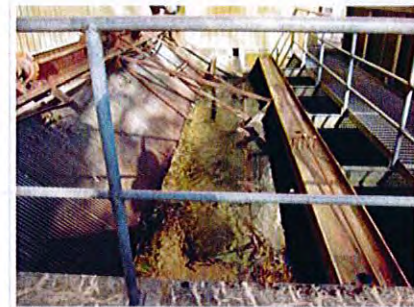
Fiskgaller, ca 60 graders lutning och ca 25 mm spaltbredd
