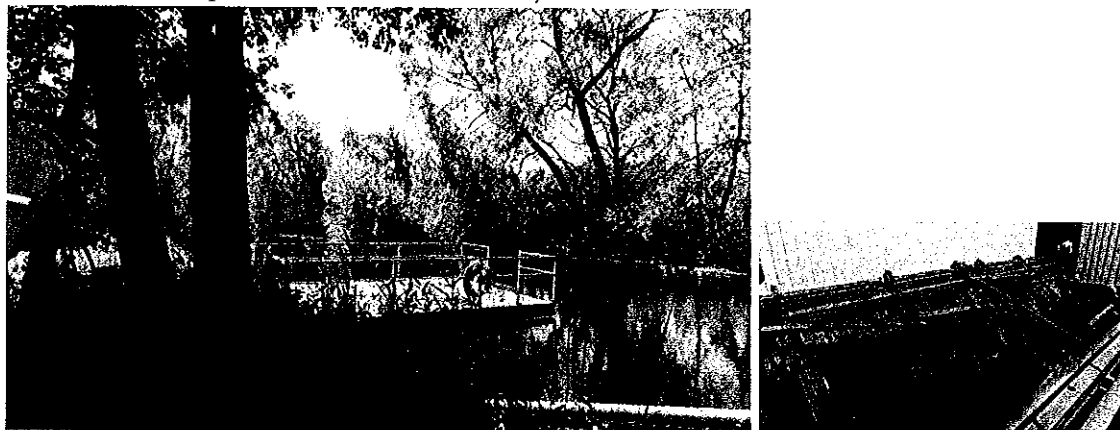
Figur 14. Dammvall vid Lilla Harrie (vänster i figur) och befintligt fiskgaller vid kraftintaget (höger i figur).
