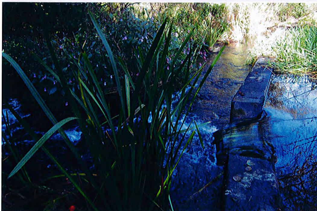
Figur 4.9 Utskov samt del av fiskväg i den nuvarande anläggningen i den södra delen av dämnet, anlagd 2010.
