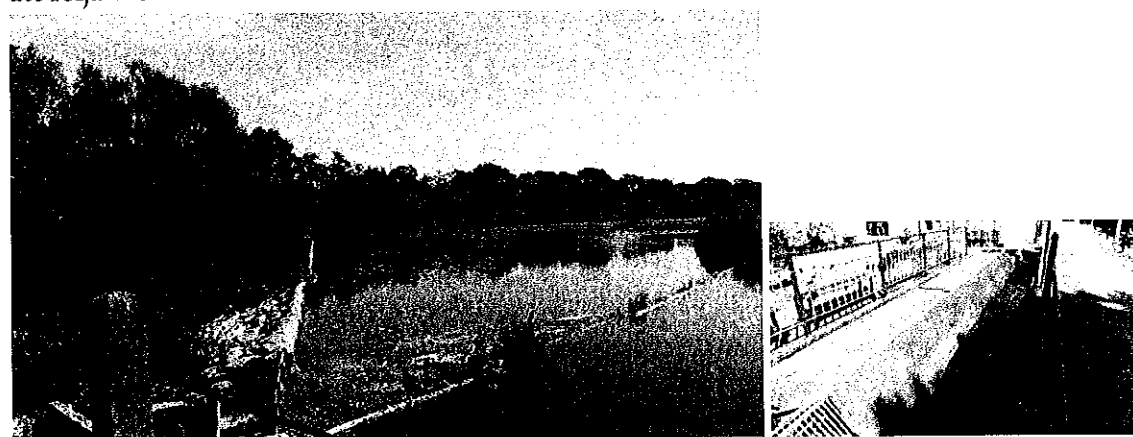
Figur 17. Dammvall vid Bösmöllan (vänster i figur) och befintligt fiskgaller vid kraftintaget (höger i figur). Foto taget vid lågflöde den 18 juni 2014.
