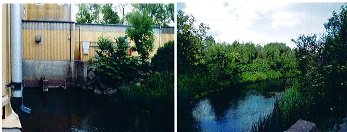
Figur 4.6 Utloppskanal från turbiner vid Farina AB sedd mot och från turbinhuset.
