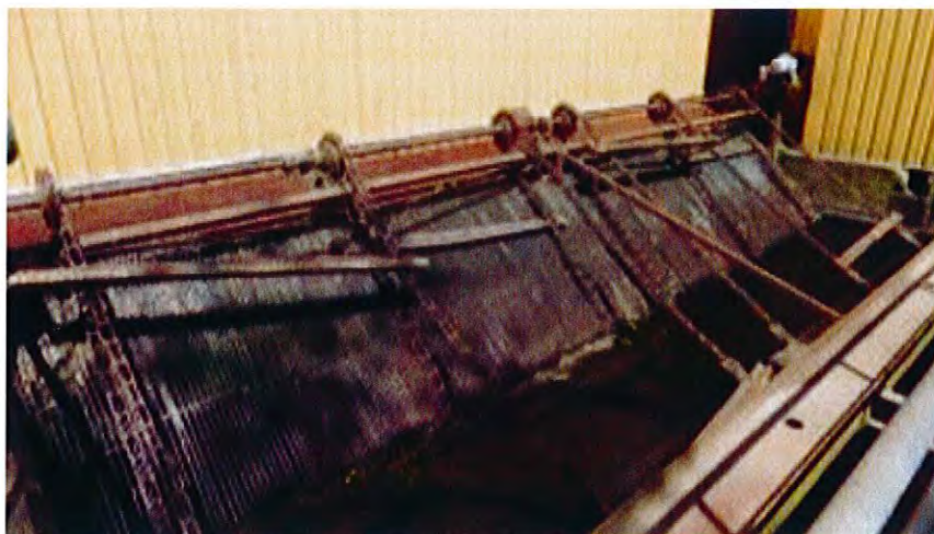
Figur 4.4 Nuvarande rens-galler med maskinell resning. Källa: Ekoll AB.
