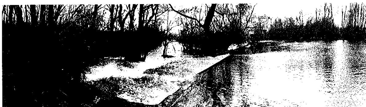
Figur 16. Fiskväg vid Lilla Harrie vid hög vattenföring. Foto taget 3 mars 2015.
