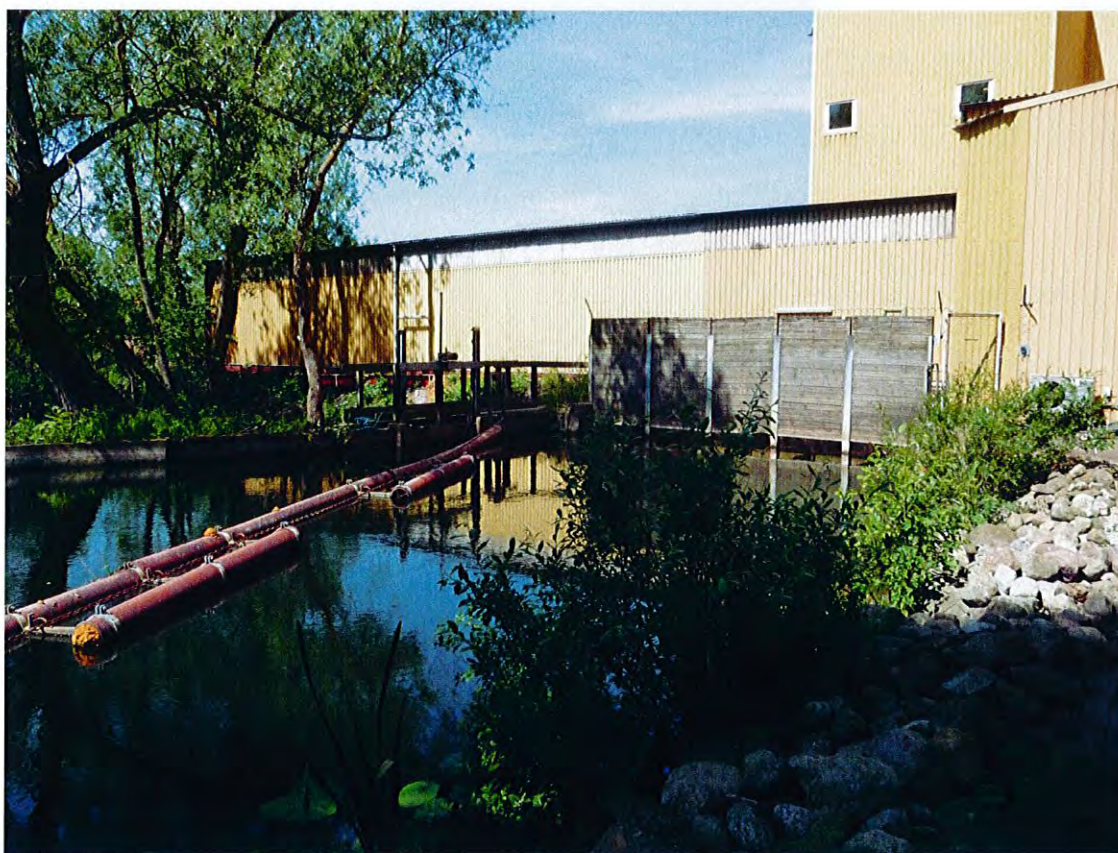
Figur 4.3 Inloppet till kraftstationen (bilden tagen uppströms).
