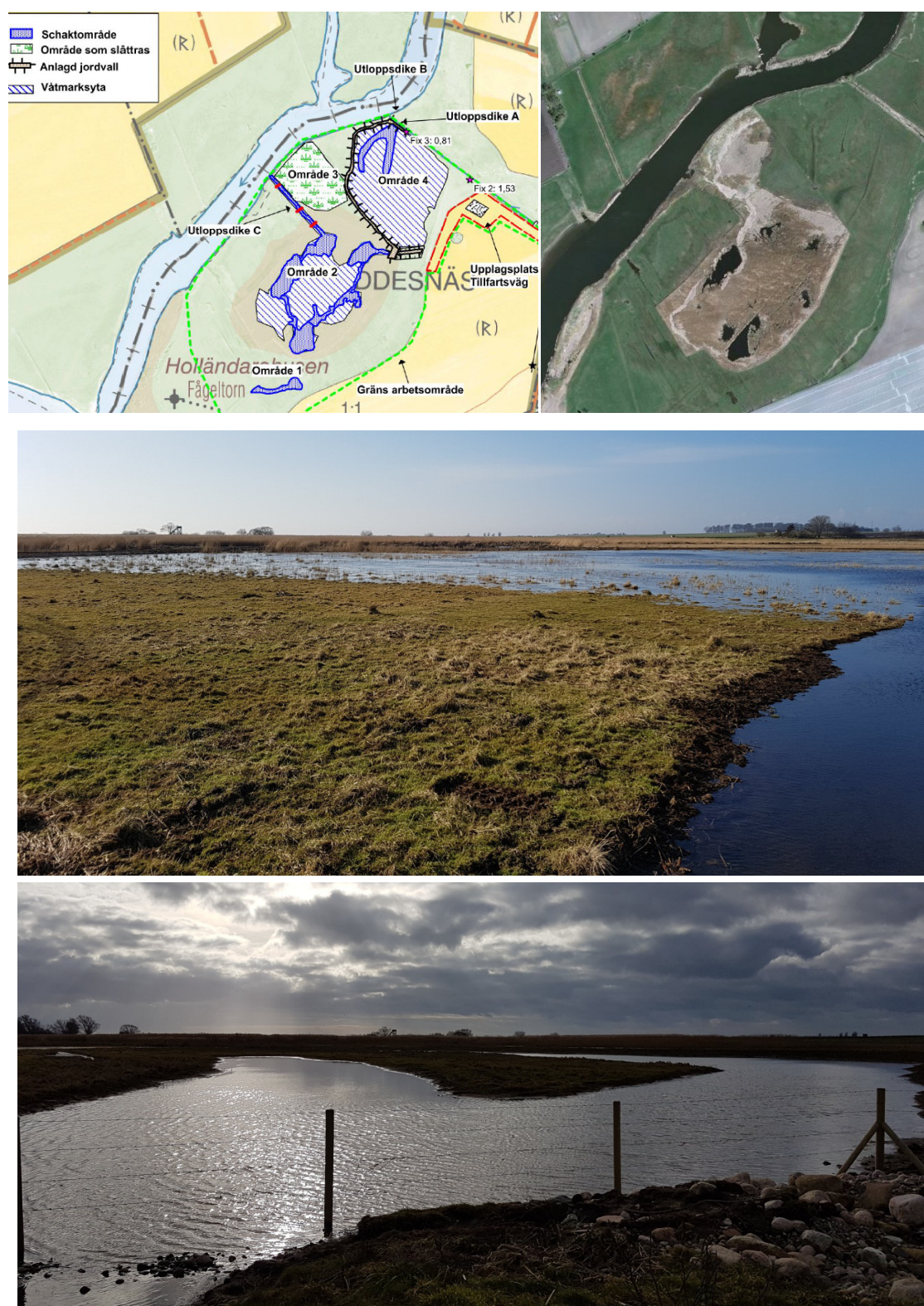
Figur 5 Holländarehusen Lödösnäs. Överst: Flygbild över våtmarksområde innan åtgärd (till höger) samt projekteringsritning (till vänster). I mitten och nederst visas vyer över färdigställd våtmark.
