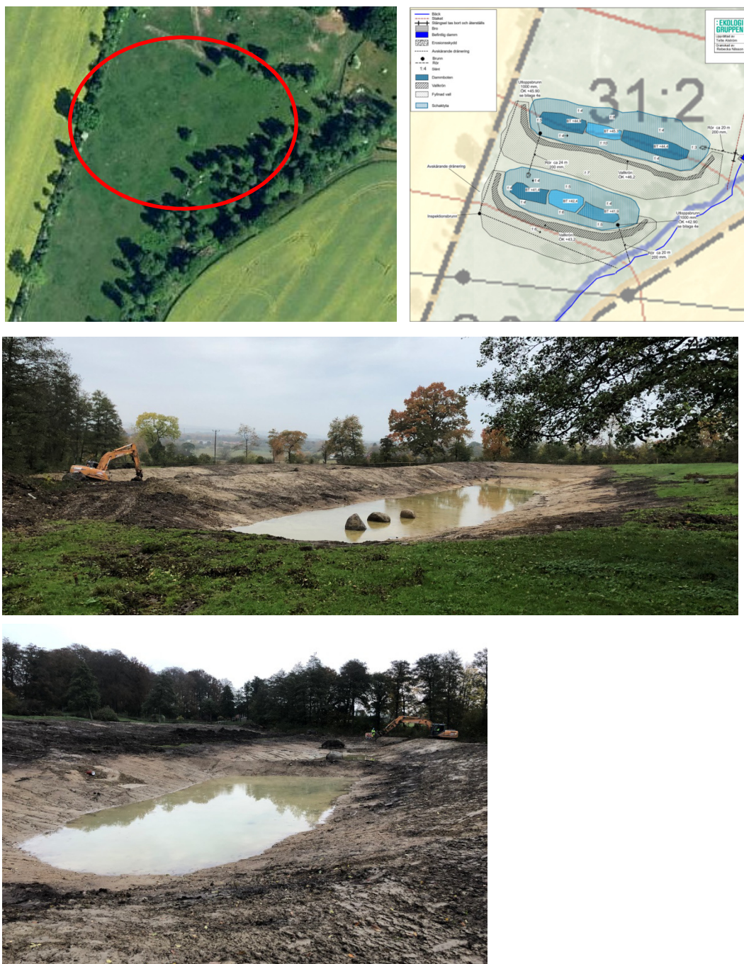
Figur 7 Hunneberga 31:2. Längst upp visas området för anläggningen före genomförande (till vänster, röd ring) och projektriting (till höger). Ovan och till vänster syns de färdigschaktade dammarna, den övre ovan och den nedre t.v.
