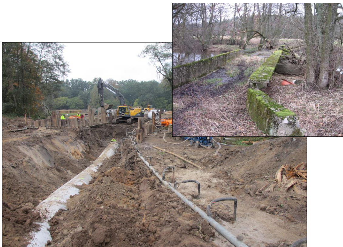
Anläggning av dykarledning under Björkaån i oktober 2014. Uppe till höger visas akvedukten som tidigare ledde huvudkanalens vatten över ån. Akvedukten finns kvar men kanalväggarna är sedan länge delvis utrivna.
