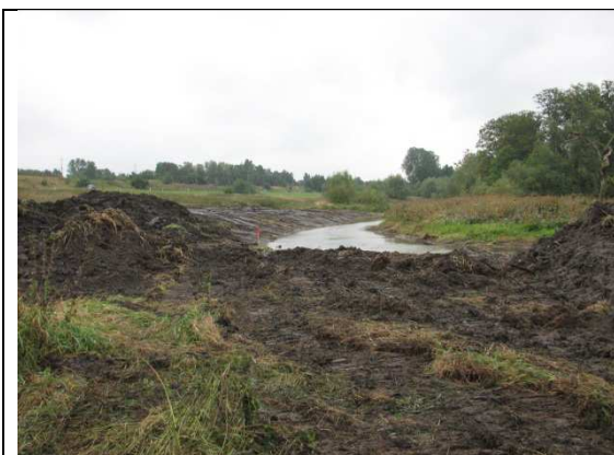
Furulund 3:1. Södra delen under arbete.
