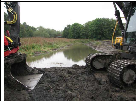
Furulund 3:1. Norra delen under arbete.
