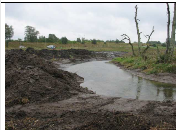
Furulund 3:1. Södra delen under arbete.
