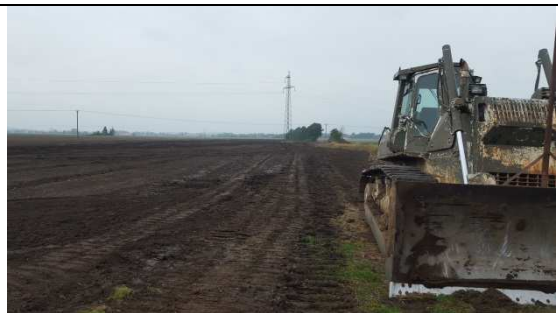
Utbanad schakt på anslutande åker.
