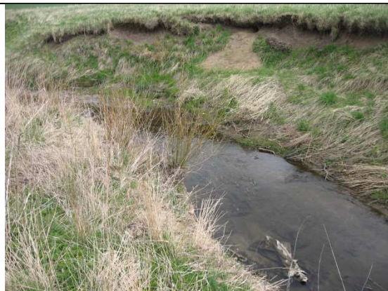
Exempel på ras och erosion längs Sularpsbäcken.
