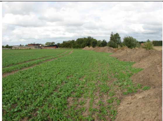
Uppgrävd jord före utbanning.
