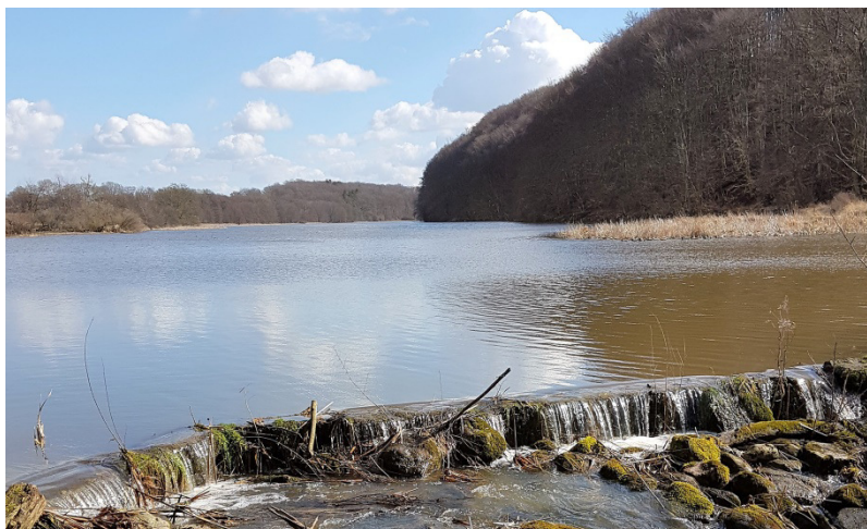
Vassens utlopp med avrinning över betongdämmet
