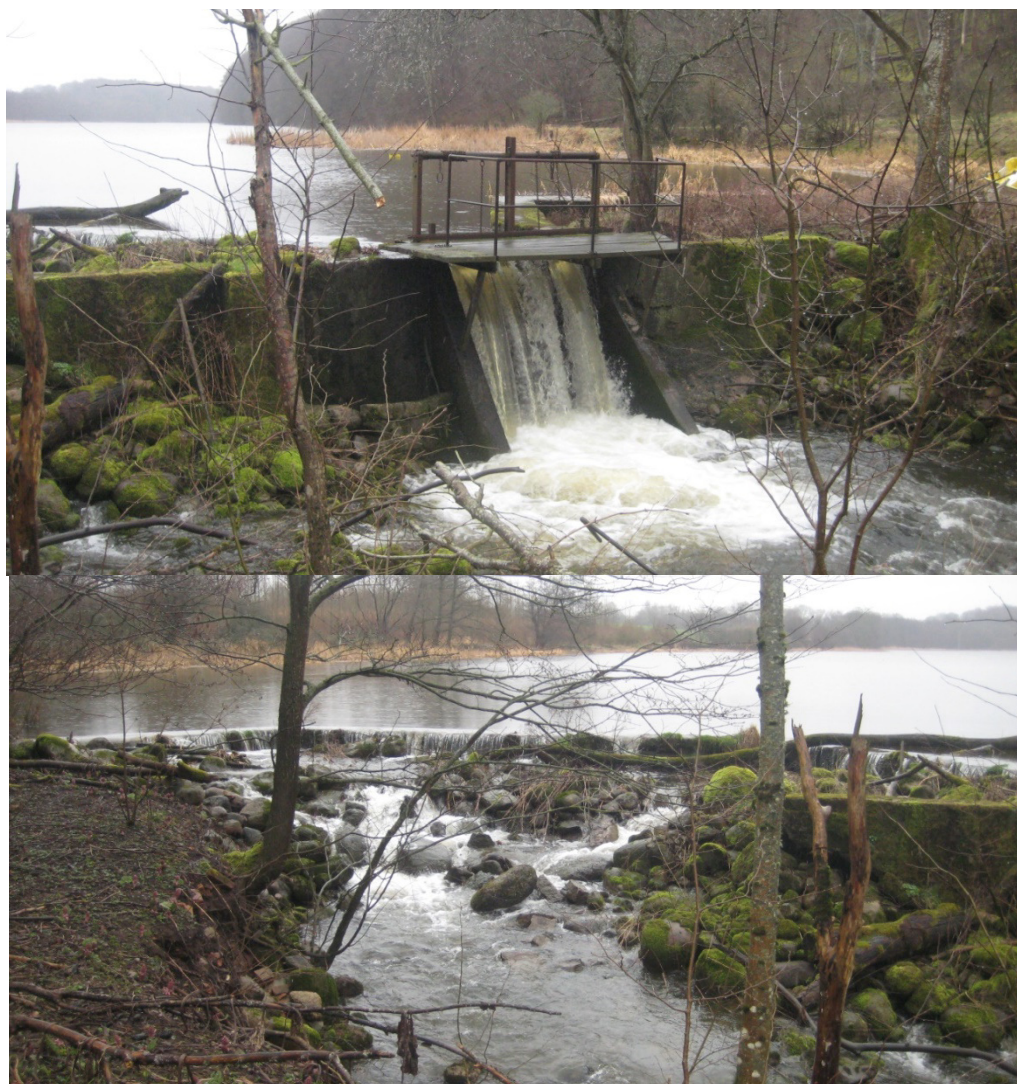
Figur 28. Delar av Vassens utloppsdämme. Överst ses det spontade (reglerbara) utskovet. Norr om (till vänster om) utskovet finns ett ca 25 m långt betongdämme. Nedre bilden visar delar av betongdämmet i norr vid ett högflöde. Betongdämmet fortsätter även söder om utskovet, men ligger där någon decimeter högre än på norra sidan varför det sällan rinner över där.
