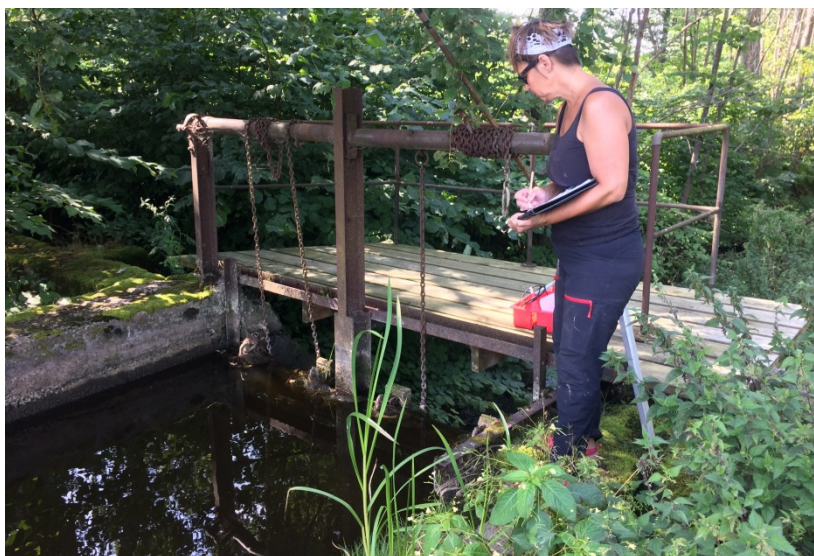
Bilden visar utskovet vid Vassens utlopp
