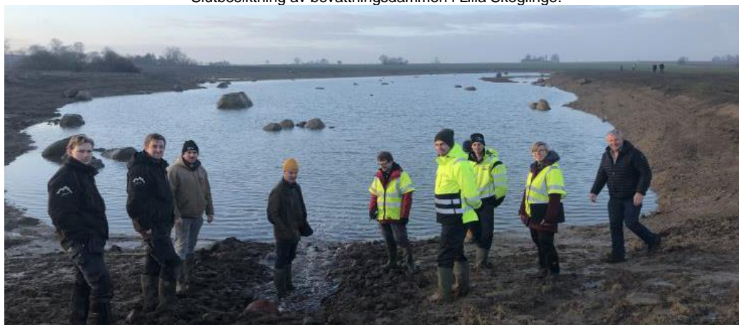
Slutbesiktning av bevattningsdammen i Lilla Skeglinge.
