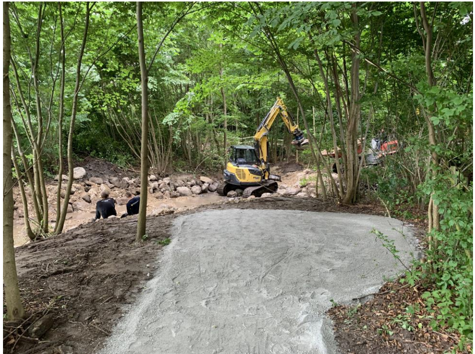
Figur 7. Utkiksplats under anläggandet av omlöpet. Informations-tavlor och bänkar kommer installeras här.
