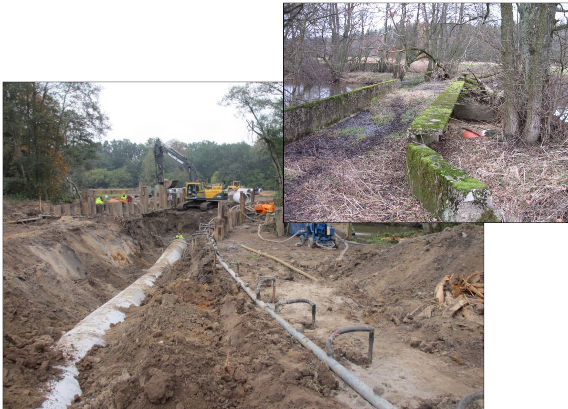
Figur 4 Anläggning av dykarledning under Björkaån i oktober 2014. Upp till höger visas akvedukten som tidigare ledde huvudkanalens vatten över ån. Akvedukten finns kvar men kanalväggarna är sedan länge delvis utrivna.
