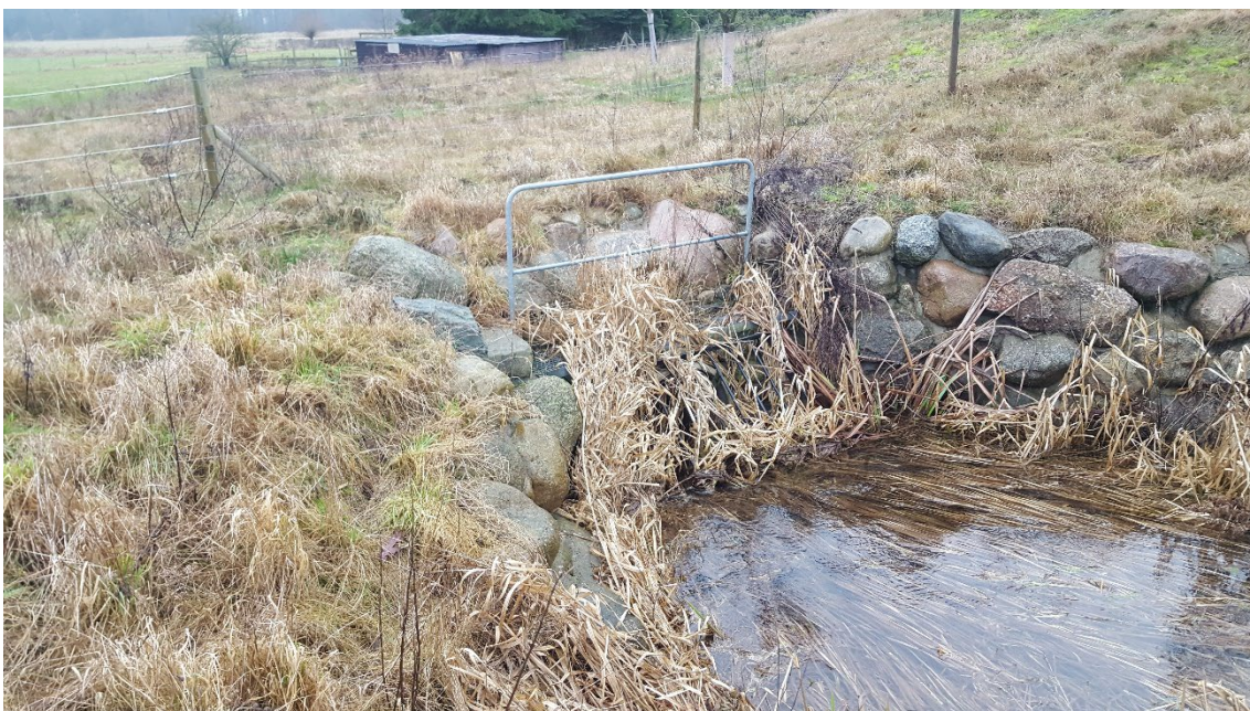
Foto 8. Exempel på galler framför rörinlopp vid D som kräver tillsyn och eventuell rensning två gånger per år. Januari 2020.
