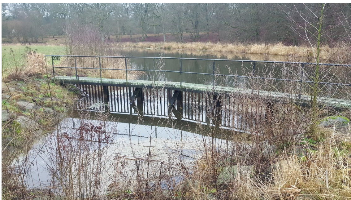
Foto 2. Metallräcke vid B, inlopp till dykarledning. Januari 2020.
