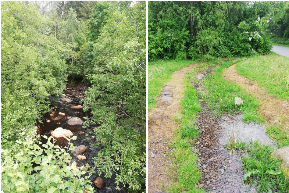
Exempel på hur diket kan utformas för att sakta ner vattnets framfart.
