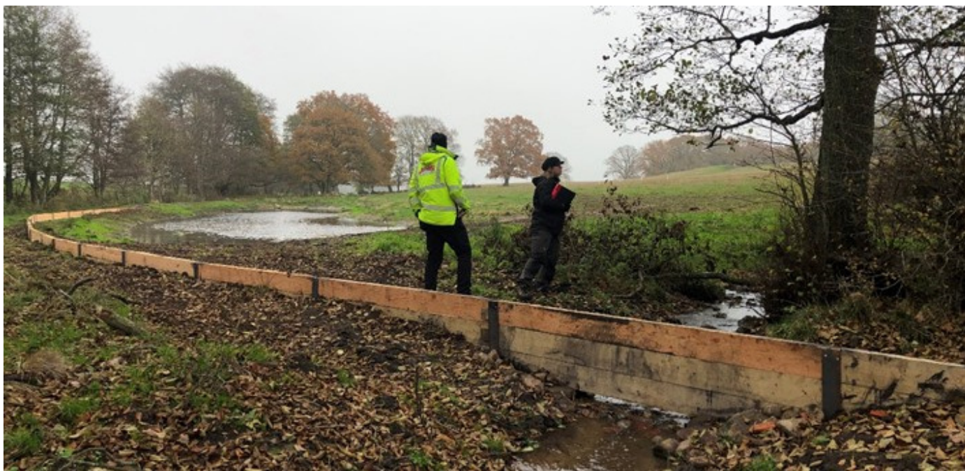
Figur 17 Vy över plankdämme och översvämningssyta på västra delen av läge 2. Vid höga flöden sker en dämning av bäcken med hjälp av plankdämnet. Vid lägre flöden rinner vattnet under det dämmande planket. Bild Tette Alström Ekologigruppen 22-11-01.
