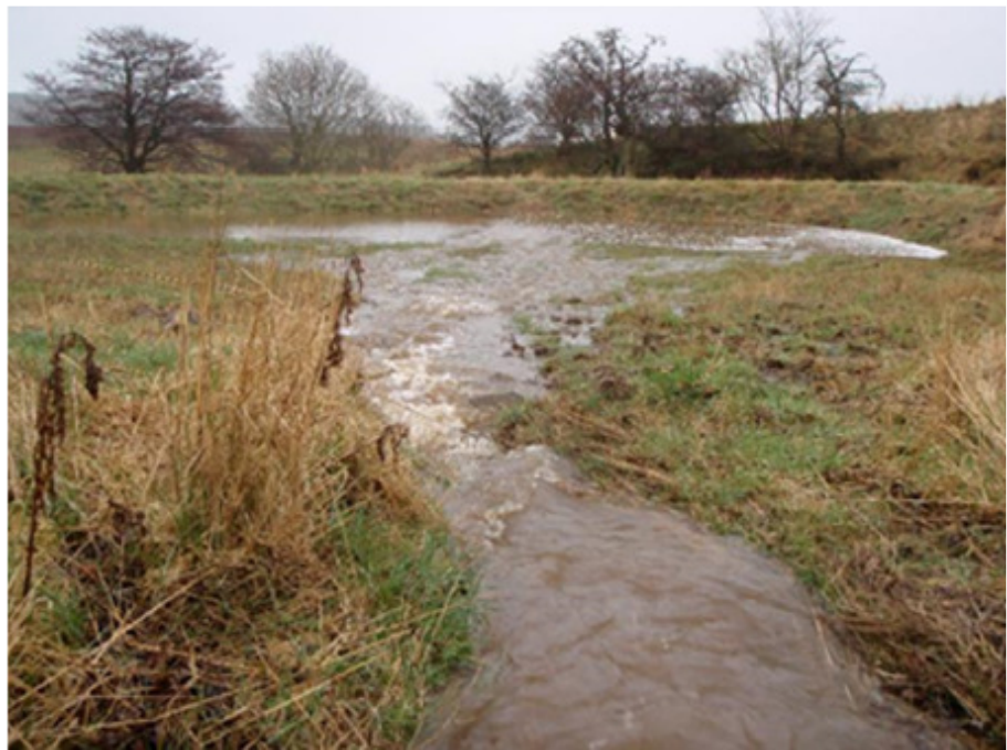
Figur 23 Exempel på fördröjning genom en uppbyggd vall, Belford Burn England
