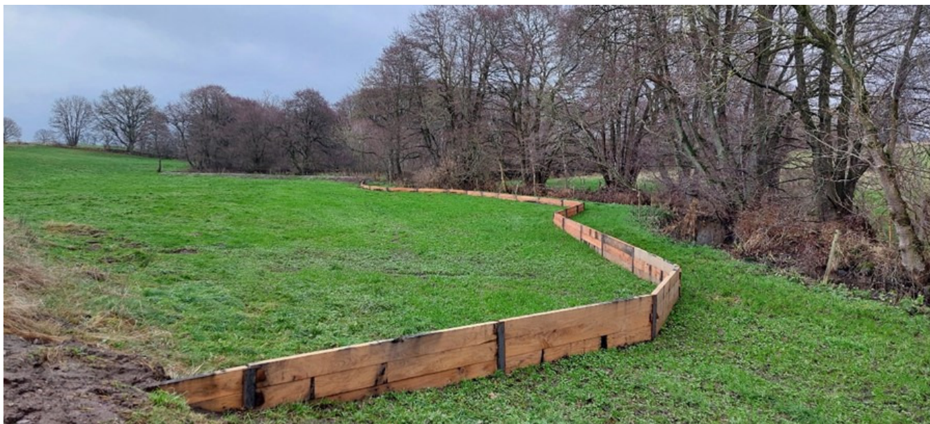
Figur 20 Plank med anslutande vall i bakgrunden åtgärdsåtgärd 4.
