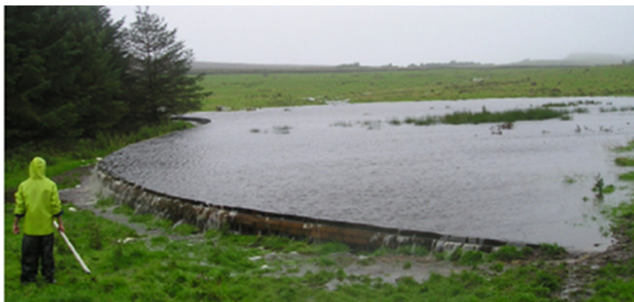
Figur 3 Exempel på ett plankdämme för temporär fördröjning inom ett mindre avrinningsområde. Vatten avleds till en svacka i betesmarken där en enkel träbarriär byggts upp. England, Belford.
