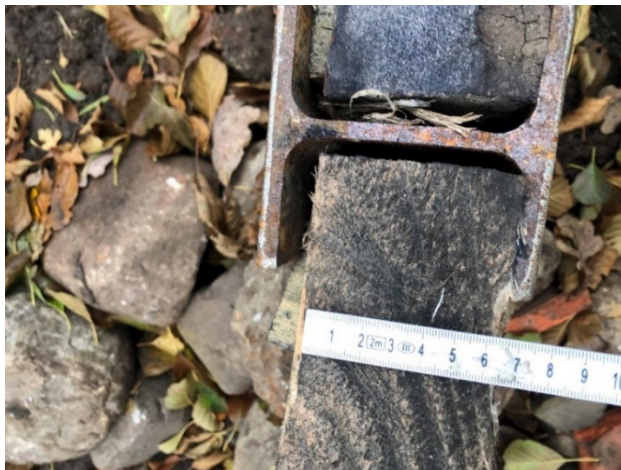
Figur 21 Planken har satts i HEA-balken. Foto Tette Alström Ekologigruppen
