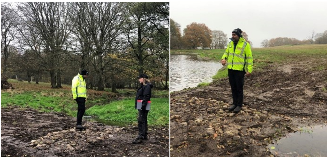
Figur 16 I det västra översvämningområdet på Vanstadtorp 10:12 (läge 2 i figur 9) avleds vattnet direkt från en bäck (tv) till en delvis utgrävd översvämningssyta (th). Bild Tette Alström Ekologigruppen
