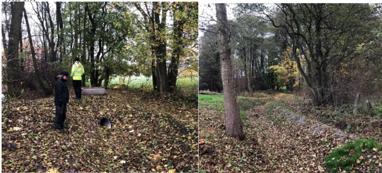
Figur 19 Till vänster utloppsbrunn i vall vid damm, med utloppsbrunn mot Eggelstad 6:18. till höger inloppsränna från brunn mot plankdämme på Eggelstad 6:18. Bild Tette Alström Ekologigruppen.
