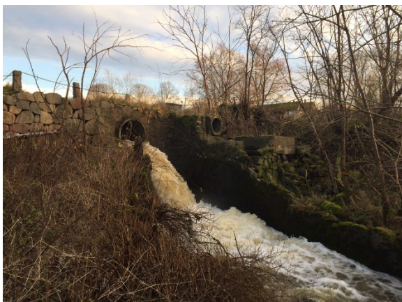
Figur 42. Gamla stendämnet i Mölledammen.
