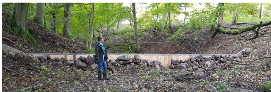
Figur 32. Vy över färdigställt övre plankdäme vid Veberöd 1:23 sett nedifrån i den övre delen av bäckravinen.
