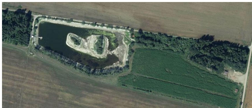
Figur 9. Flygbild över Skarhult 13:36 före anläggning. Till vänster i bild ses den befintliga dammen som nu går ihop med den nya dammen. Foto Eniro.
