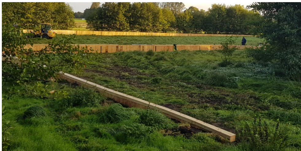
Figur 27 Vy över de dämmande planken under entreprenadarbeten
