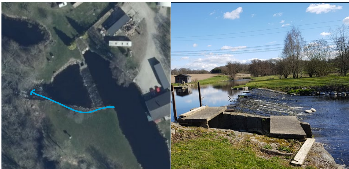
Figur 24 Överblick över kvarnområdet före anläggning av omlöpet vid Rolsberga kvarn. I den vänstra bilden är läget för omlöpet inritat (blå pil). I den högra bilden ses läget för omlöpet mellan trädraden och det befintliga dämmet.
