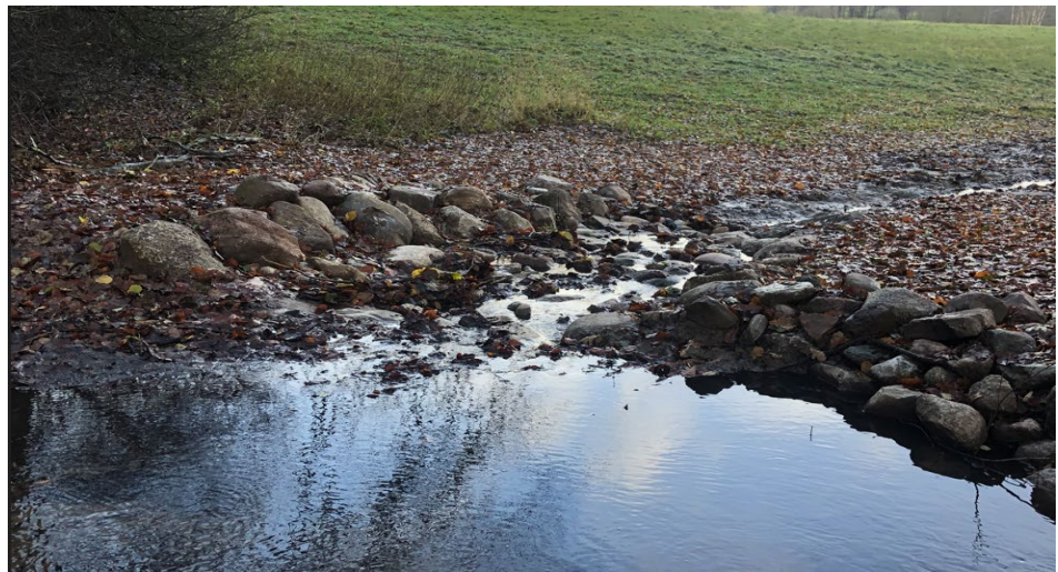
Figur 29 Inlopp från bäcken vid Veberöd 5:5 som avleder vatten vid högre flöden.
