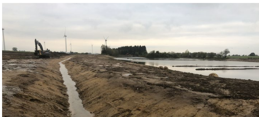
Figur 11. Vy över den färdiga dammen på Skarhult 13:36 och den tidigare anlagda dammen (i bakgrunden). Till vänster i bild ses det dike som leder lågvattenföringen förbi dammen.
