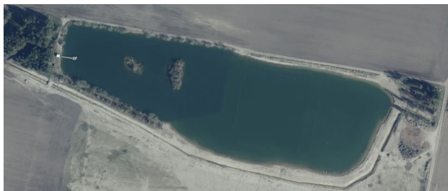
Figur 10. Flygbild över den färdiga dammen på Skarhult 13:36, källa SCALGO.
