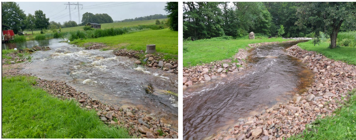
Figur 23 Rolsberga kvarn. Till vänster omlöpets början, till höger omlöpets fortsättning nedströms
