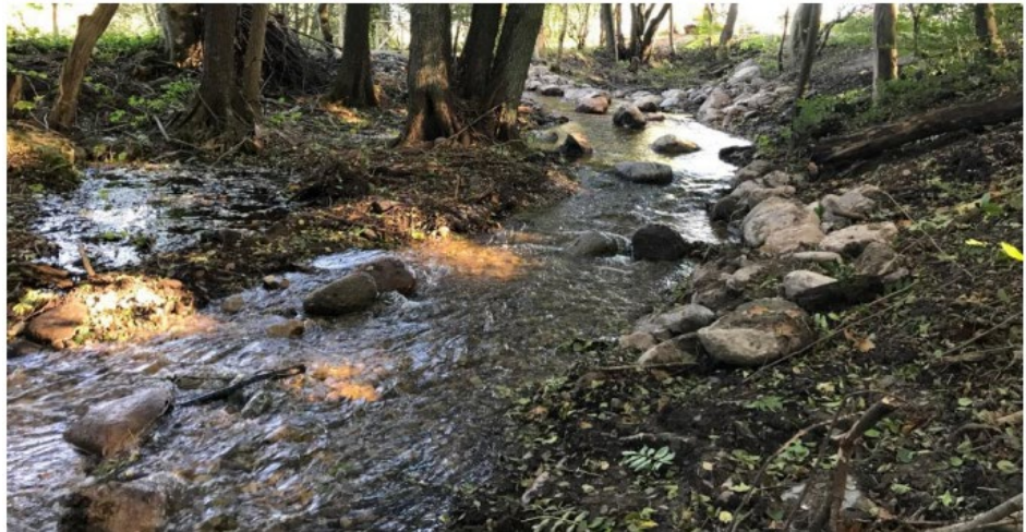
Figur 21 Det ca 160 m långa omlöpet med strömförbättrande substrat av grus och sten
