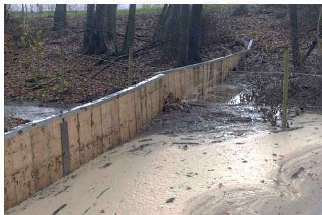
Figur 34. Vy över färdigställt plankdäme vid Veberöd 1:23 sett från uppströmssidan i den nedre delen av bäckravinen. Bilden är tagen efter höglöden och här ser man att konstruktionen delat på sig på grund av en skarv i det överliggande metallbandet.
