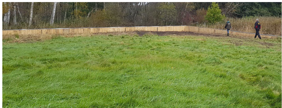
Figur 30 Del av uppsatt plankdämme
