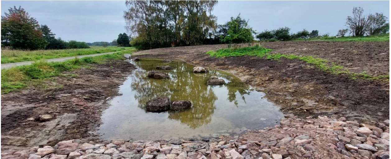
Figur 8. En av de två mindre dammarna för biologisk mångfald, fokus groddjur. Dammarna ger också en renande effekt på passerande vatten. Foto: Siri Wahlström, Ekologigruppen.
