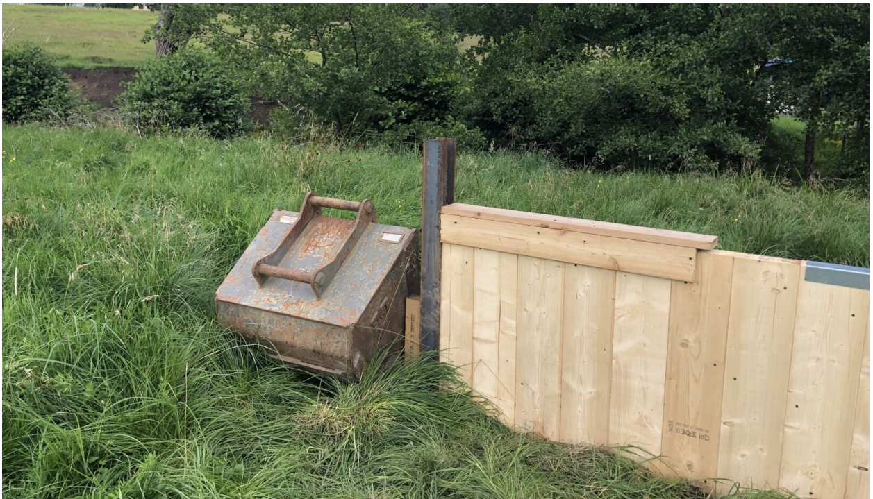
Figur 11. Konstruktionsuppbyggnad för plankdämme uppströms Veberöd. Sående kärnfuru i kombination med HEA-balkar och överliggande skydd. Foto: Tette Alström, Ekologigruppen.
