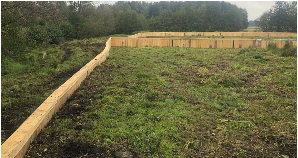
Figur 9. Plankdämme uppströms Veberöd. Foto: Tette Alström, Ekologigruppen.
