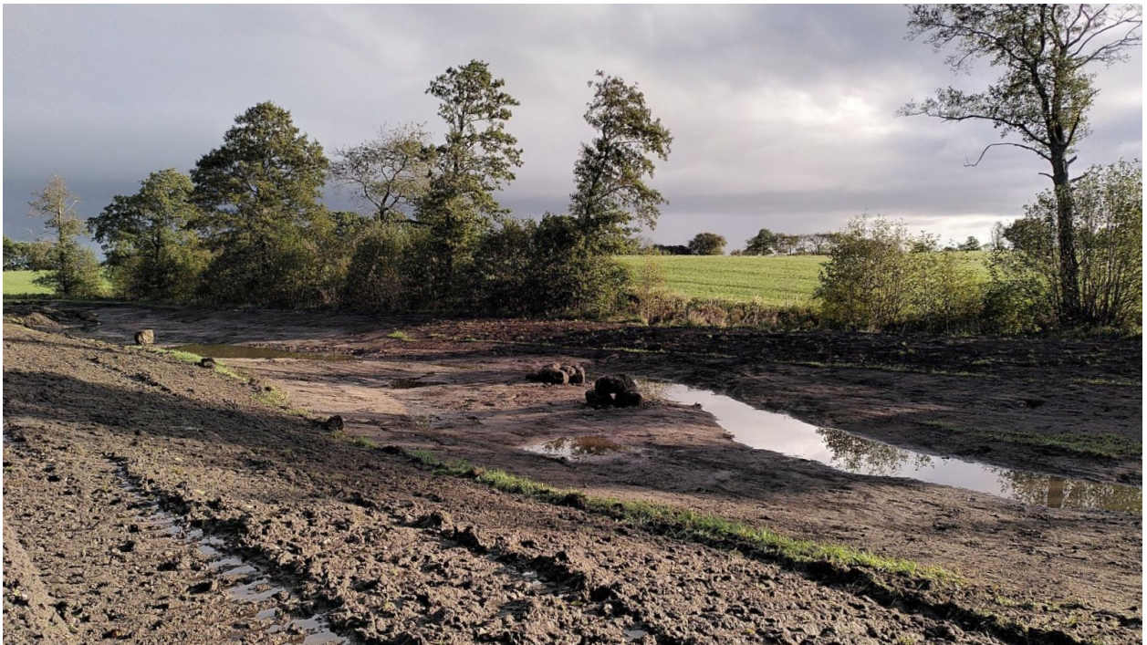
Figur 6. En ny bäckfåra har anlagts som löper parallellt med ett jordbruksdike och leder in vatten i en våtmark för näringsrening (se figur 4). Foto: Siri Wahlström, Ekologigruppen.
