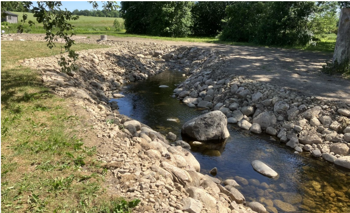
Figur 13. Faunapassagen vid Rolsberga kvarn – nedre delen. Sten och block har lagts ut för att bromsa flödes hastigheten vid högre flöden och föra att botten ska ha en divers struktur med hålrum och bakvatten. Foto Filip Hvitlock, Ekologigruppen.
