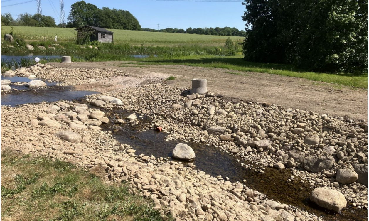
Figur 12. Faunapassagen vid Rolsberga kvarn – övre delen. Kvarndammen syns i bakgrunden. Strax nedströms inloppet finns en traktorövergång. Två mätbrunnar har installerats för att kunna övervaka vattennivåerna och därmed flödesfördelningen i damm och omlöp. Foto Filip Hvitlock, Ekologigruppen.
