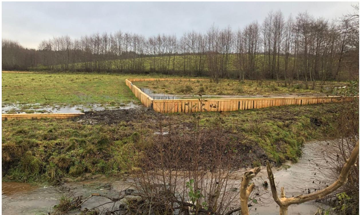
Figur 10. Plankdämme uppströms Veberöd strax efter första högflödessituationen i november 2023. Foto: Tette Alström, Ekologigruppen.
