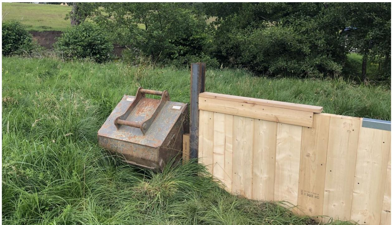
Figur 11. Konstruktionsuppbryggnad för plankdämme uppströms Veberöd. Sående kärnfuru i kombination med HEA-balkar och överliggande skydd. Foto: Tette Alström, Ekologigruppen.
