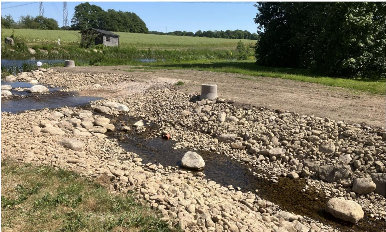
Figur 12. Faunapassagen vid Rolsberga kvarn – övre delen. Kvarndammen syns i bakgrunden. Strax nedströms inloppet finns en traktörövergång. Två mätbrunnar har installerats för att kunna övervaka vattennivåerna och därmed flödesfördelningen i damm och omlöp. Foto Filip Hvitlock, Ekologigruppen.
