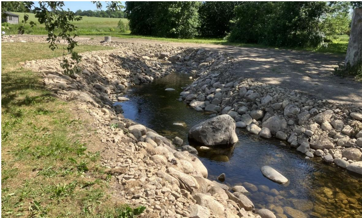
Figur 13. Faunapassagen vid Rolsberga kvarn – nedre delen. Sten och block har lagts ut för bromsa flödeshastigheten vid högre flöden och föra att botten ska ha en divers struktur med hålrum och bakvatten. Foto Filip Hvitlock, Ekologigruppen.
