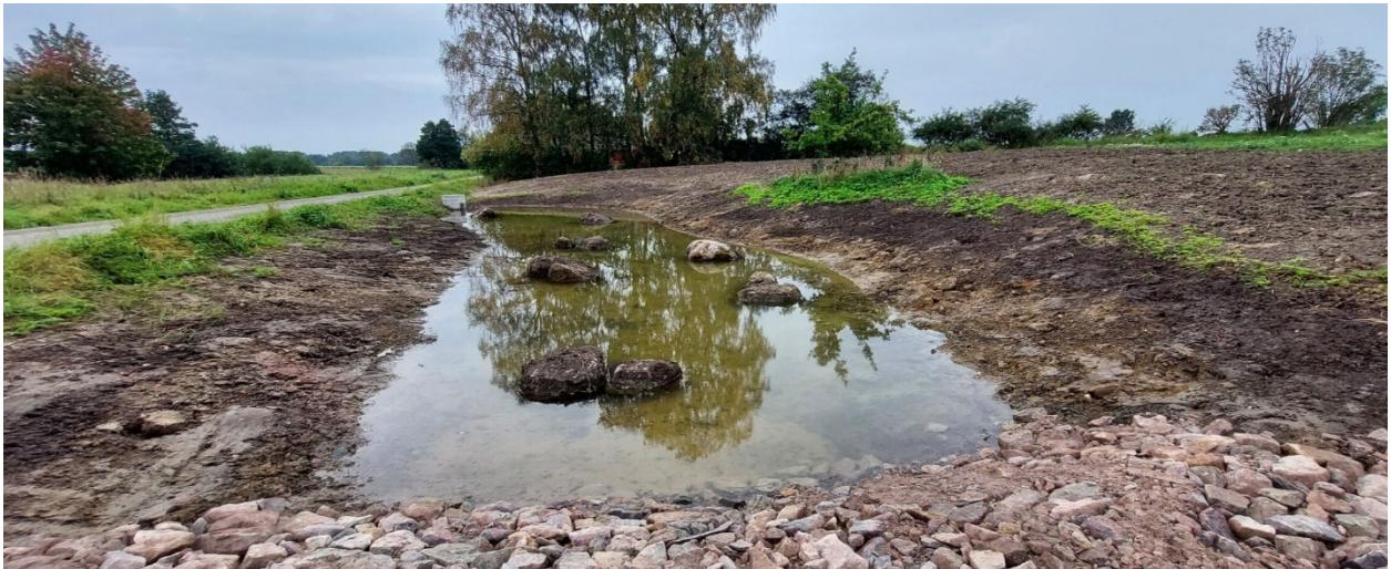
Figur 8. En av de två mindre dammarna för biologisk mångfald, fokus groddjur. Dammarna ger också en renande effekt på passerande vatten.
