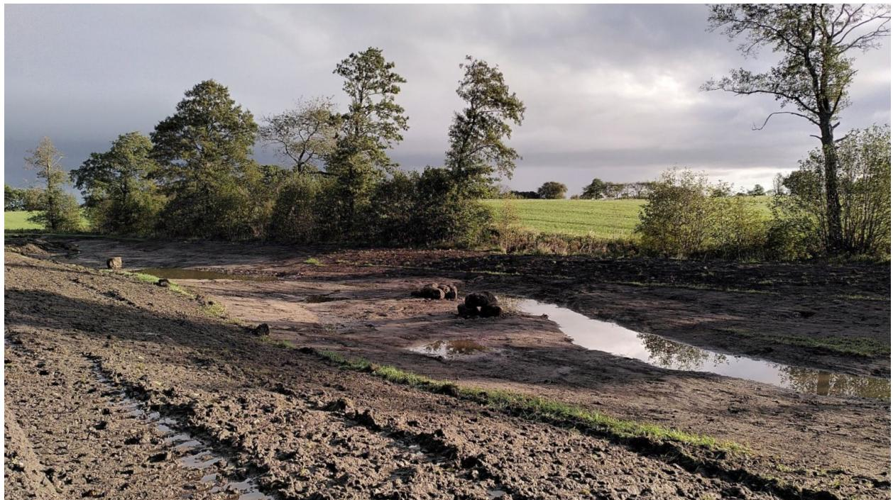
Figur 6. En ny bäckfåra har anlagts som löper parallellt med ett jordbruksdike och leder in vatten i en våtmark för näringsrenning (se figur 4).
