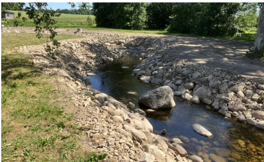
Figur 15. Faunapassagen vid Rolsberga kvarn – nedre delen. Sten och block har lagts ut för att bromsa flödes hastigheten vid högre flöden och föra att botten ska ha en divers struktur med hålrum och bakvatten. Foto Filip Hvitlock, Ekologigruppen.
