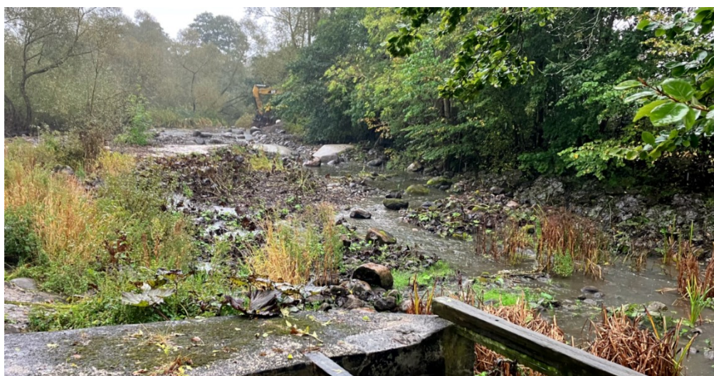
Tolånga övre dämme. Dämme och fiskväg – Före åtgärder, vid lågflöde. Fiskvägen gick torr (till stor del p.g.a. kollapsade planksättar). Foto: Ekologigruppen.
