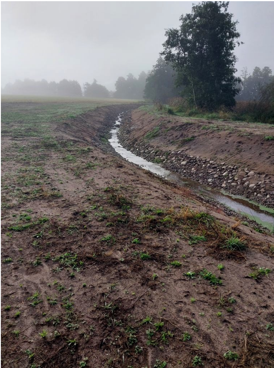
Lilla Torpsbäcken. Färdigt anlagt omlöp. Slänterna är klädda med sten närmare boten och sås in med gräs närmare släntkrönet. Foto: Ekologigruppen.
