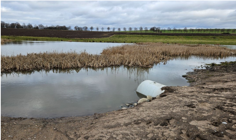
Lilla Torpsbäcken. Passerbar grövre betongledning vid damm 4. Foto: Ekologigruppen.
