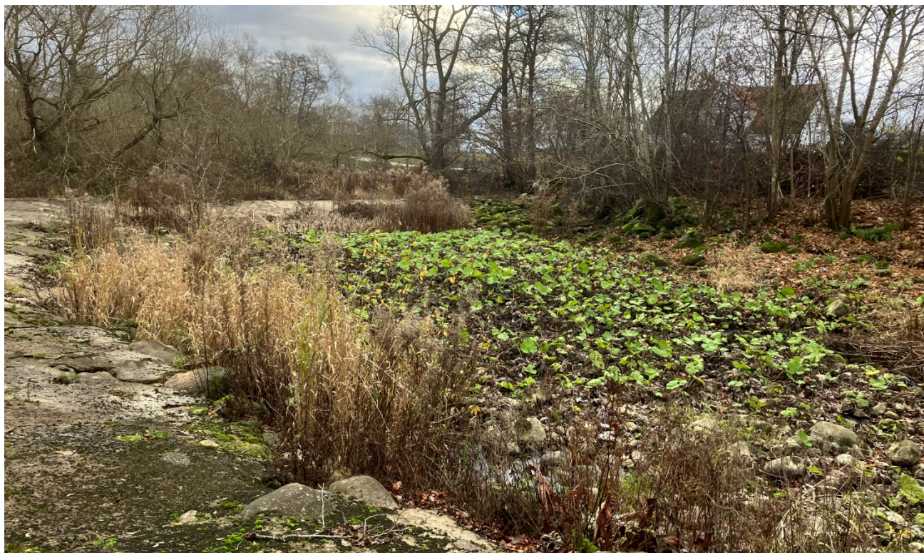
Tolånga övre dämme. Dämme och fiskväg – Före åtgärder, vid lågflöde. Fiskvägen gick torr (till stor del p.g.a. kollapsade planksättar). Foto: Ekologigruppen.
