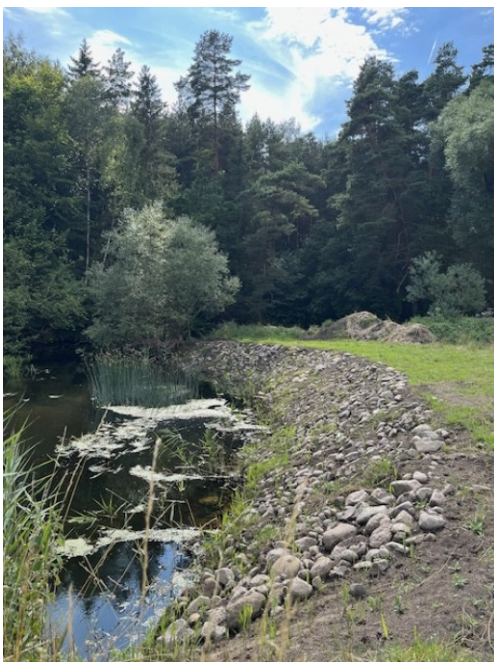
Bild 4. Exempel efter åtgärd där den fasade kanten stabiliserats med hjälp av sten.
