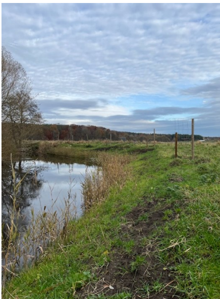
Bild 3. Exempel efter åtgärd där den fasade kanten stabiliserats genom grässådd.
