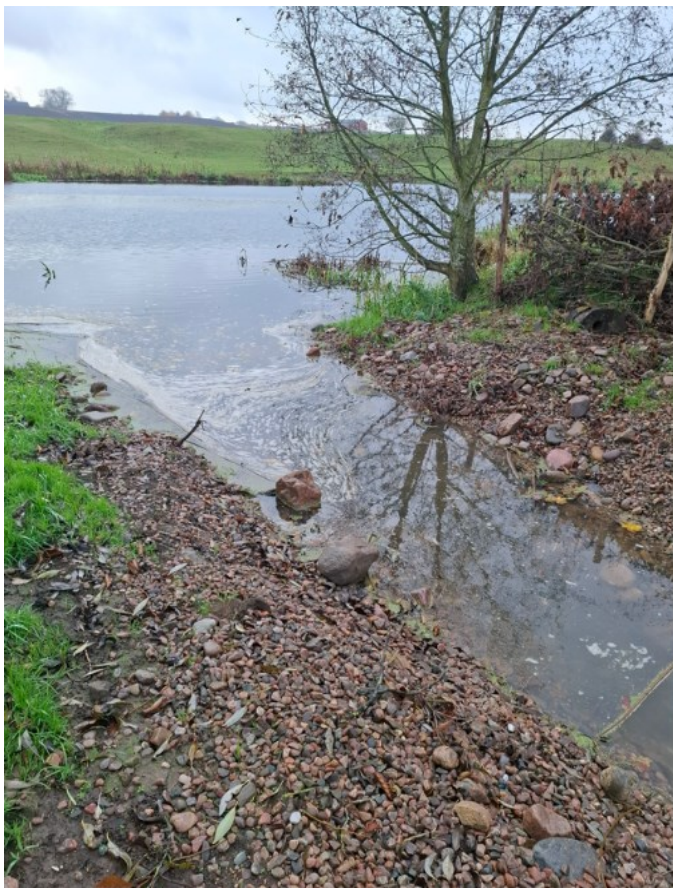
Rinnebäck. Utloppsdiket är låglutande för att möjliggöra passage för fisk. Foto: Ekologigruppen.
