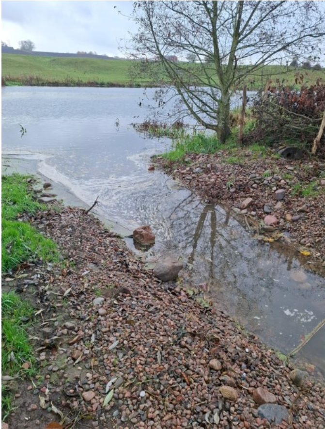
Rinnebäck. Utloppsdikey är låglutande för att möjliggöra passage för fisk. Foto: Ekologigruppen.
