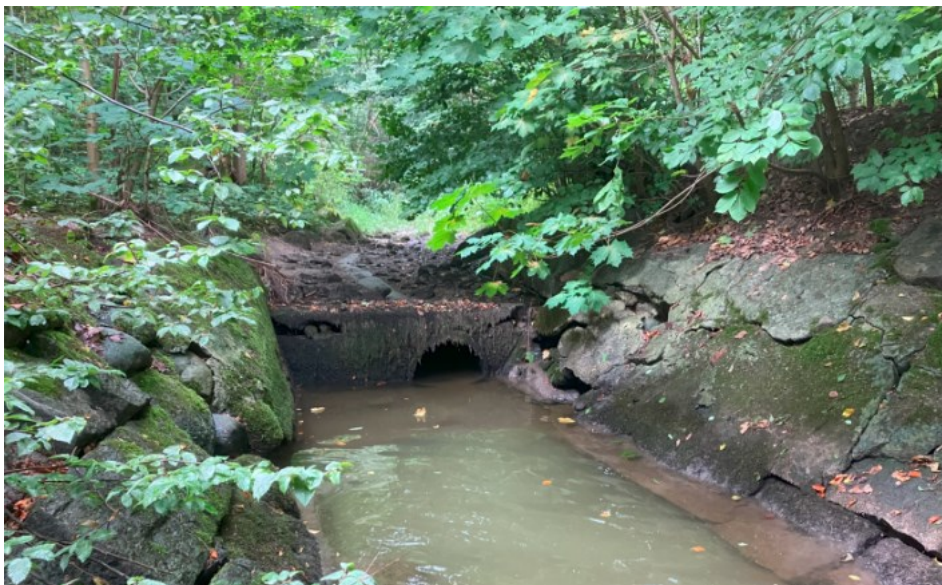
Grybybäcken. Före åtgärder. Betongklacken med trummans mynning vid lågflöde. Höjdskillnaden i kombination med hög infiltrationsgrad i den grusiga jordmånen gör att bäckfåran uppströms klacken är torrlagd vid lågflödesförhållanden. Foto: Ekologigruppen.
