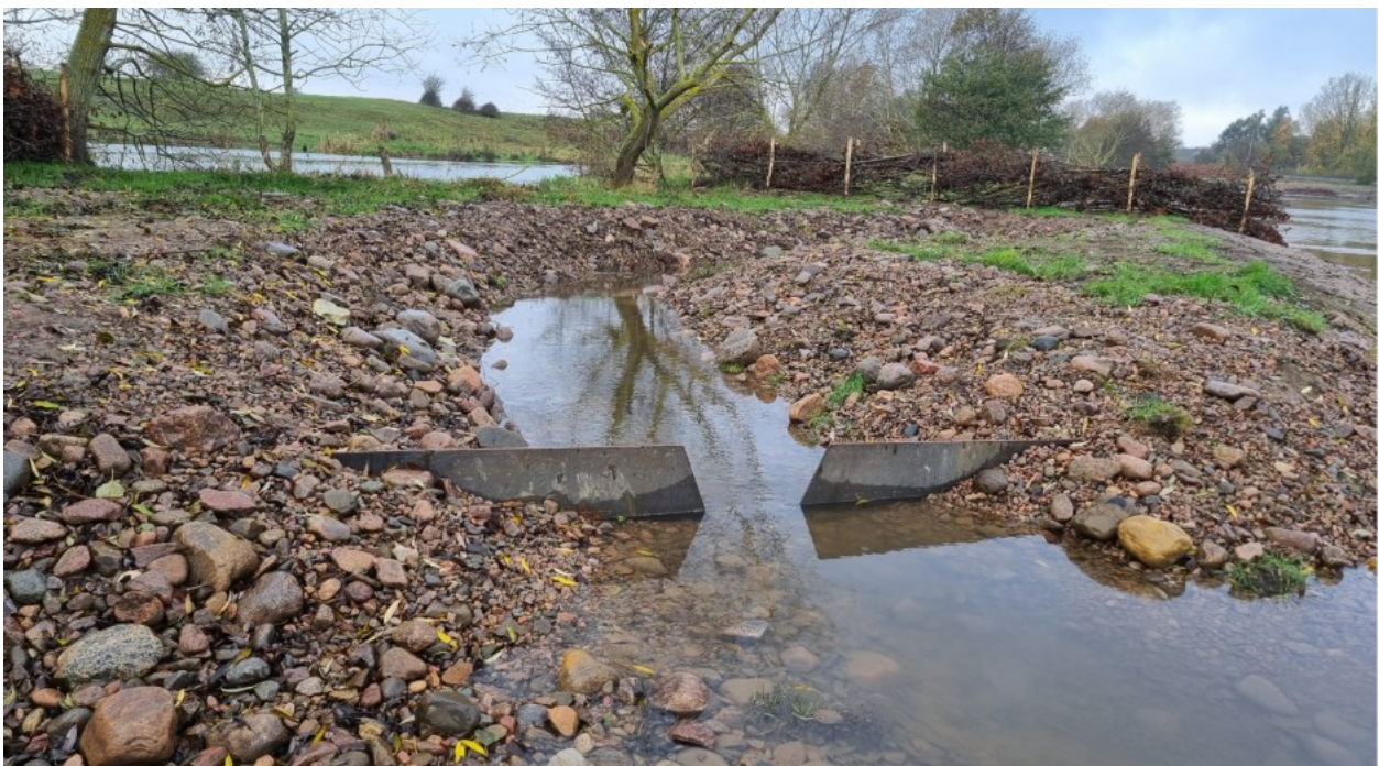
Rinnebäck. Bestämmande sektion i utloppet gör att vattennivåerna i våtmarken kan variera, men inte stiga för högt. Träpalissaderna är anlagda för att hindra betesdjur från att trampa sönder utloppsdiket. Foto: Ekologigruppen.
