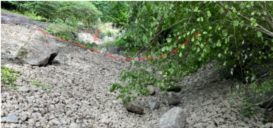
Grybybäcken. Efter åtgärder. Fördjupad vattenfåra möter mjukt upp befintlig botten cirka 55 m uppströms tidigare betongklack. Pil markerar sten för jämförelse med bild före ovan. Foto: Ekologigruppen.
