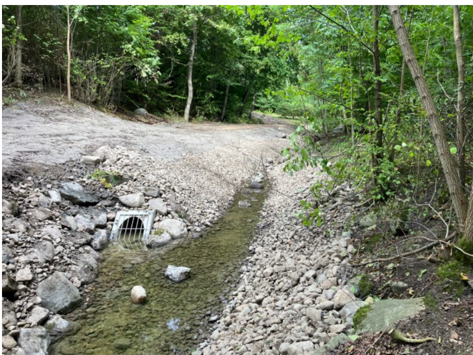
Grybybäcken. Efter åtgärder. Bild från cirka fem meter uppströms tidigare betongklack. Nytt trumöga 10 m uppströms tidigare mynning. Fördjupad vattenfåra som stiger med lutning om 2% för att möta upp befintlig botten uppströms. Foto: Ekologigruppen.
