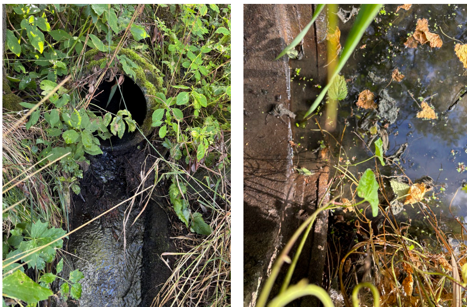
Figur 15 Inlopp tar in vatten, utlopp går nästan torrt. Våtmark K9A 2026-08-24.
