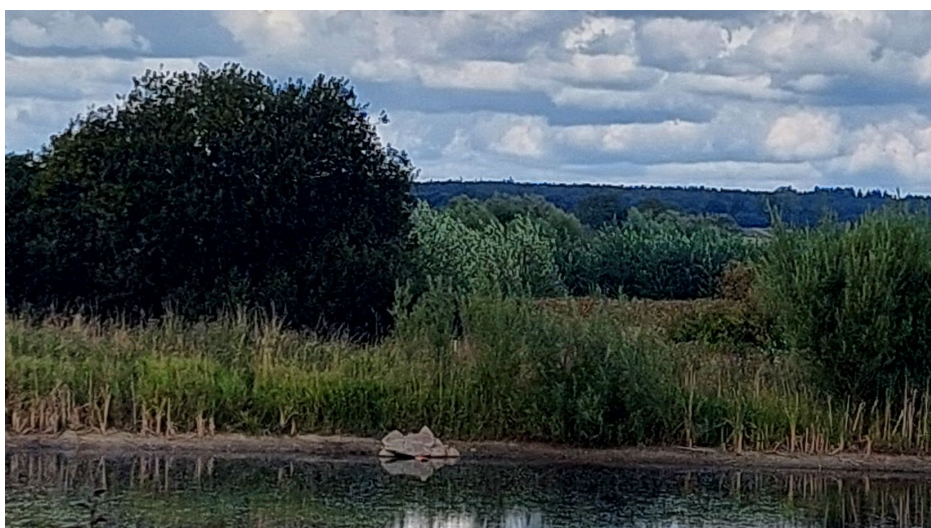
Figur 11 Bild på utloppsledningen, som ligger precis i vattenytan vid fältbesöket.
