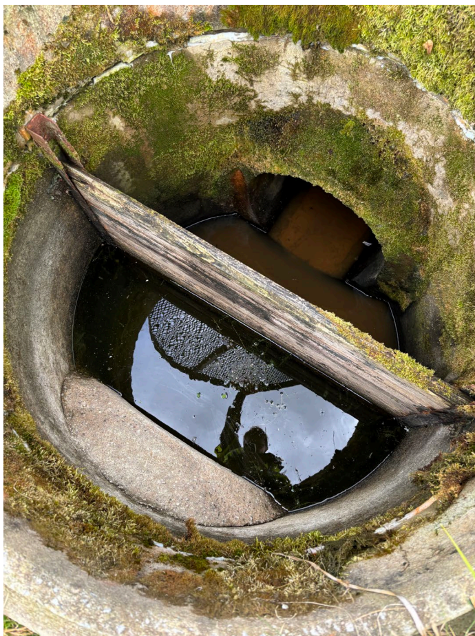
Figur 19 Utlopp från våtmark K242 till brunn med plansättare. Vattenyta i våtmark ca 0,4 m under plansätter, vattennivå nedströms plansättare ca 0,6 m. 2026-08-21
